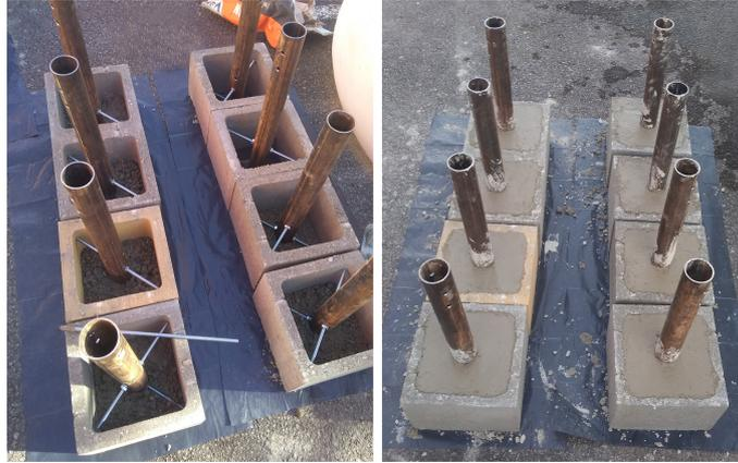
FIGURE 4.20 – Réalisation des blocs en béton.
