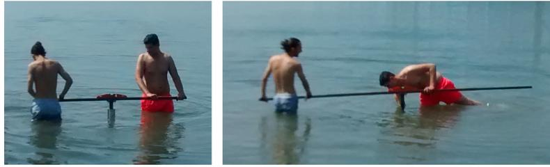
FIGURE 4.57 – Adaptation du bras de levier de la clé d’implantation.
