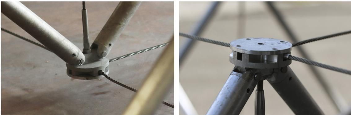
FIGURE 4.4 – Nœuds internes : nappe inférieure (à gauche) et nappe supérieure (à droite).
