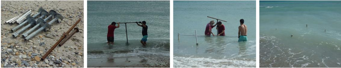
FIGURE 4.63 – Implantation des 4 appuis à l'aide du 2<sup>ème</sup> modèle de système d'implantation - Durée : 45 min.
