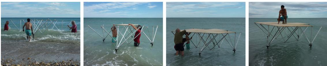
FIGURE 4.66 – Installation du prototype avec la fixation des plaques - Durée : 15 min.
