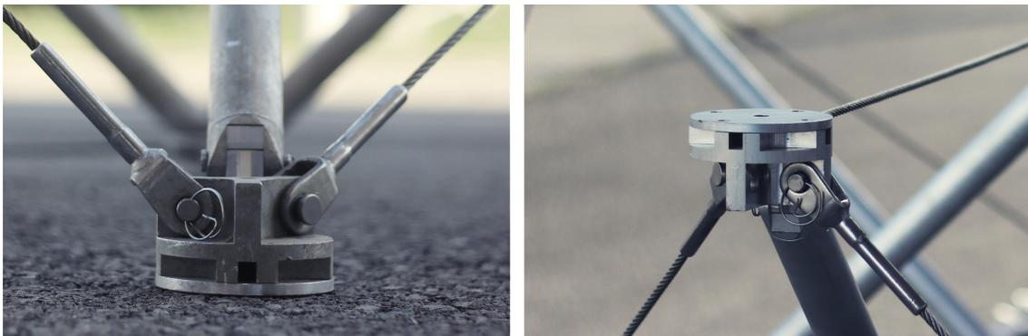
FIGURE 4.5 – Nœuds de coin : nappe inférieure (à gauche) et nappe supérieure (à droite).
