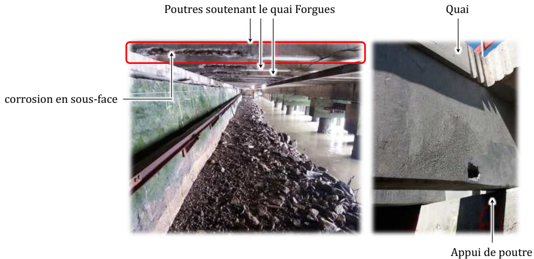
Figure 2.23 : Photographies des poutres de quai étudiées
