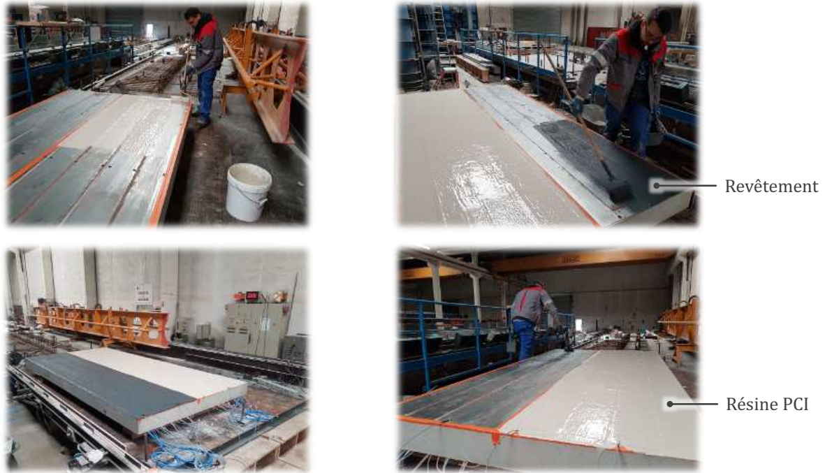
Figure 5.12 : Application de deux revêtements
