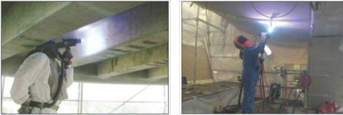
Figure 1.31 : Projection de zinc en sous-face de structures [56]
