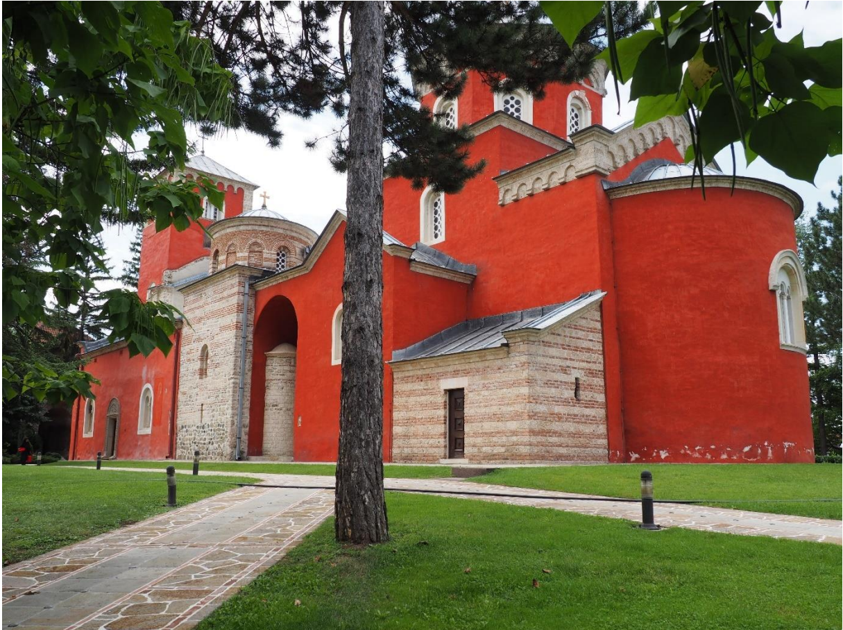
Fig. 92 : Žiča, Saint-Sauveur, vue sud-est
