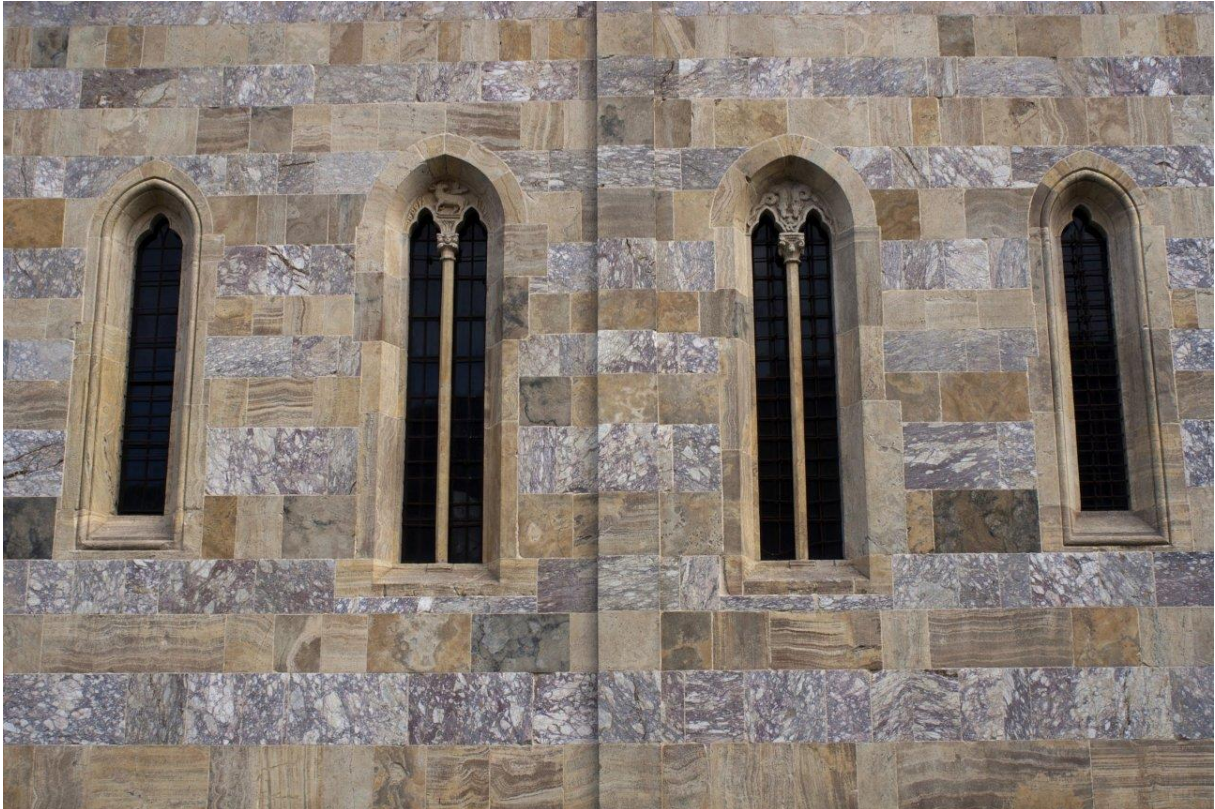
Fig. 137 : Dečani, église du Pantocrator, appareil de la façade nord
