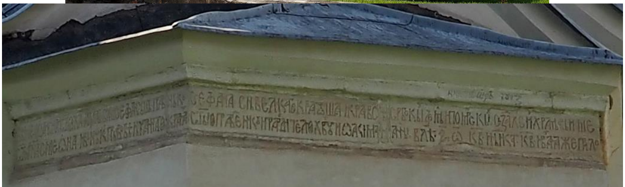
Fig. 190 : Studenica, chapelle Saints-Joachim-et-Anne, dite l'église du Roi ( Kraljeva crkva ), vue sud-est. Détail de l'inscription dédicatoire à la base du toit
