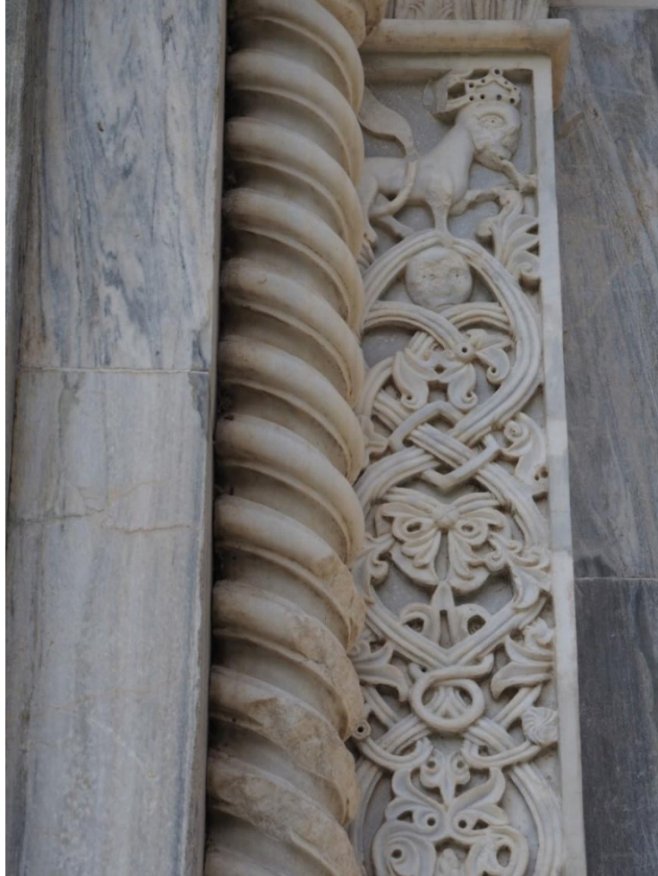
Fig. 68 : Studenica, église de la Vierge, montant ouest du portail sud, détail (Photo Maréva U) (Texte p. 203)
