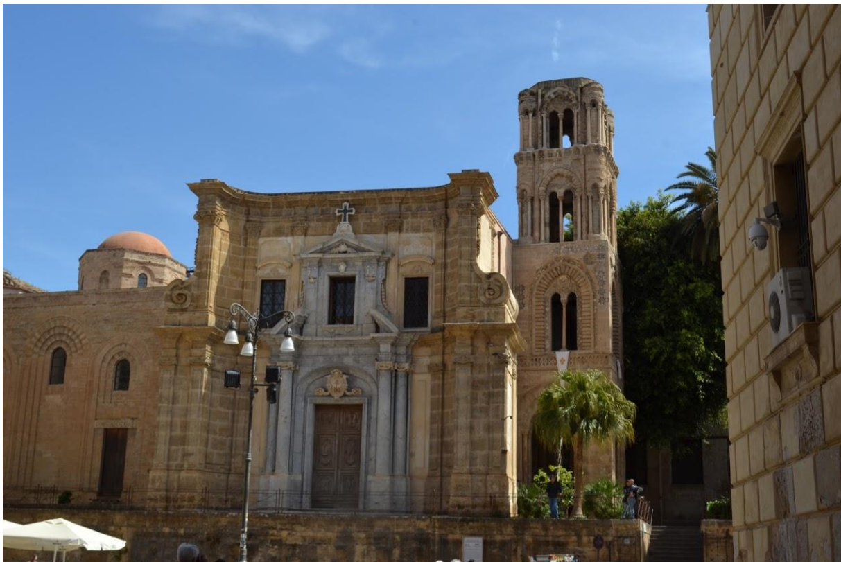
Fig. 96 : Palerme, Martorana, vue façade nord avec le campanile
