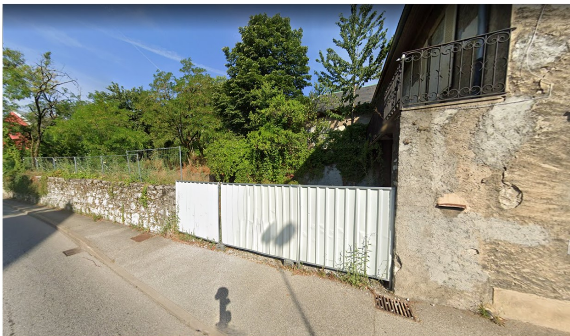
Photographie 27 : Installation d'une clôture en tôle ondulée et d'un grillage, à la suite du démantèlement du campement, pour empêcher sa reconstitution. Source : capture Google Street View, 23 avril 2021.
