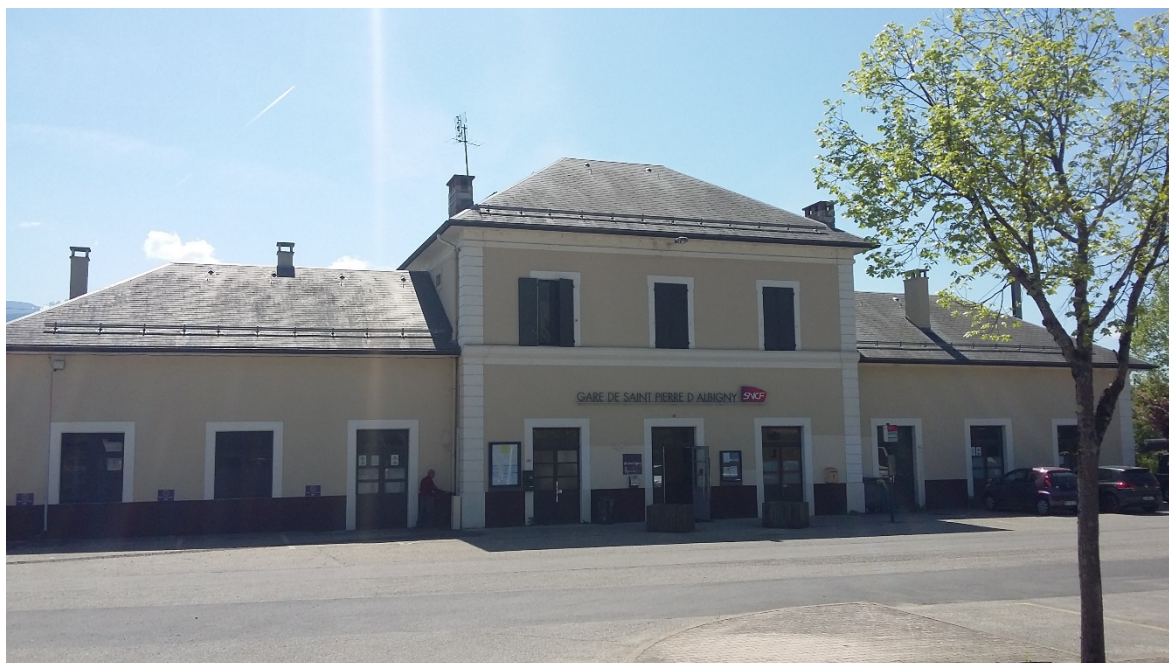
Photographie 10 : Façade principale de la gare de Saint-Pierre-d'Albigny. Source : cliché Rafik Arfaoui, 24 avril 2018.
