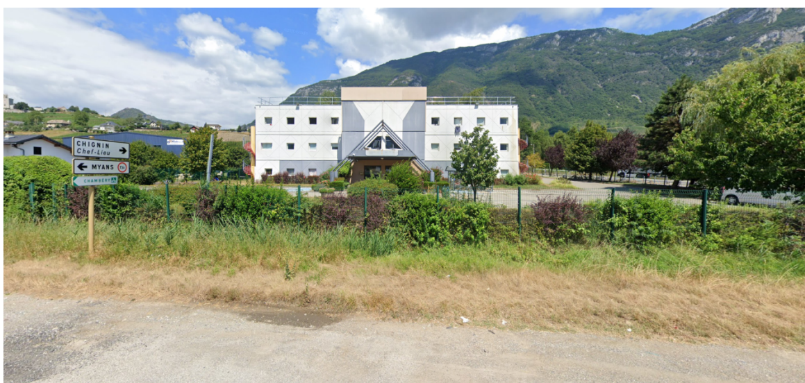
Photographie 12 : Le PRAHDA de Chignin, installé dans un ancien hôtel Formule 1. Source : Google Street View .
