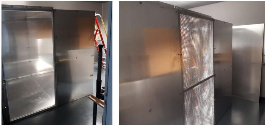
Figure 2.53 : La construction de la chambre blindée.
