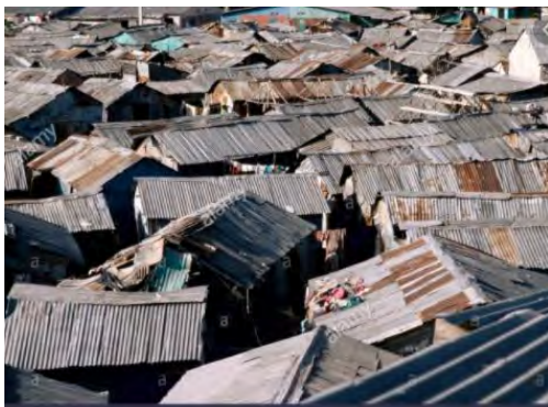
Image 5: toiture en tôle des habitats en 1990
