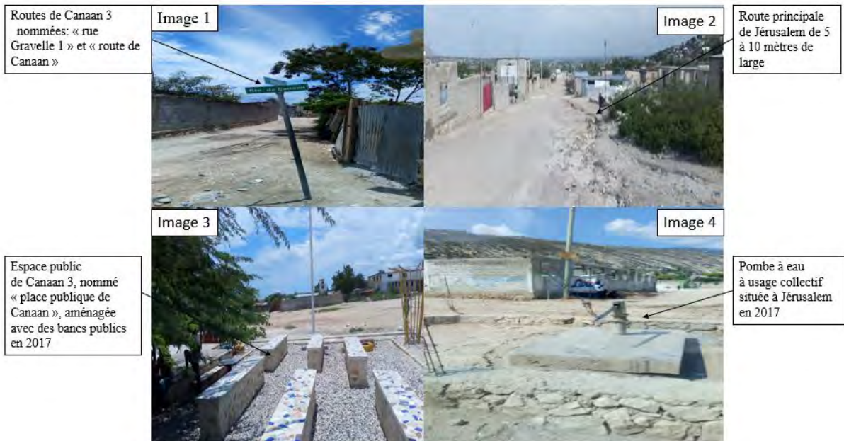
Figure 37 : Des dispositifs techniques et spatiaux observés
