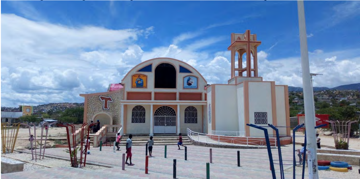
Figure 60 : Eglise catholique de Sainte Famille dans le sous-quartier Canaan 3
