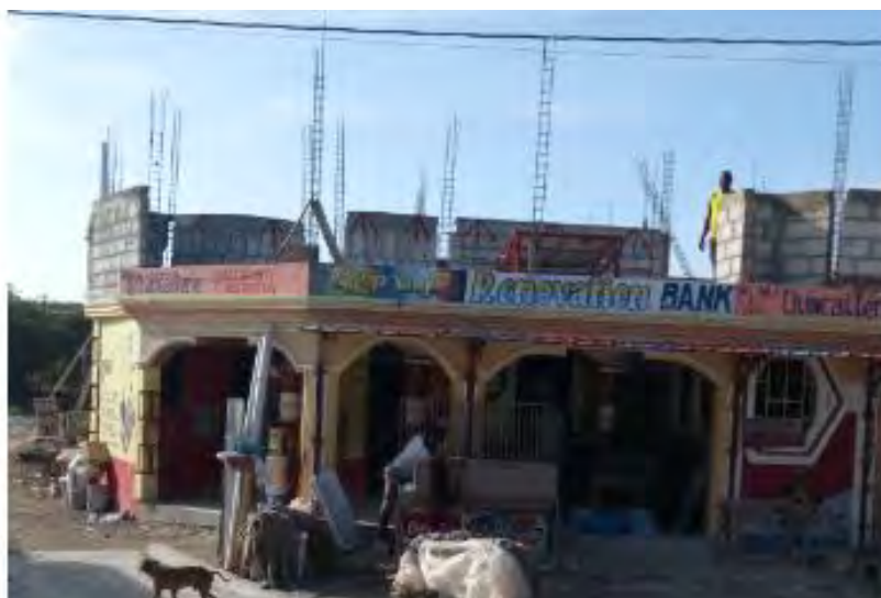
Figure 69 : Petit commerce alimentaire (Boutik en créole) dans le sous-quartier Canaan 3
