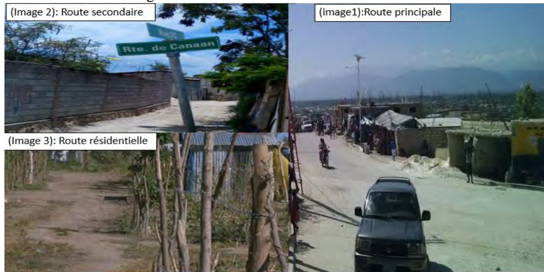
Figure 45 : Infrastructures routières à Canaan
