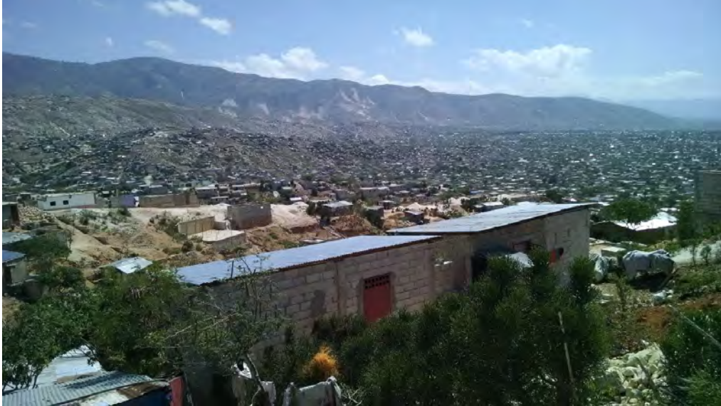
Figure 13: Vue du quartier de Canaan, du Centre au Sud en 2019
