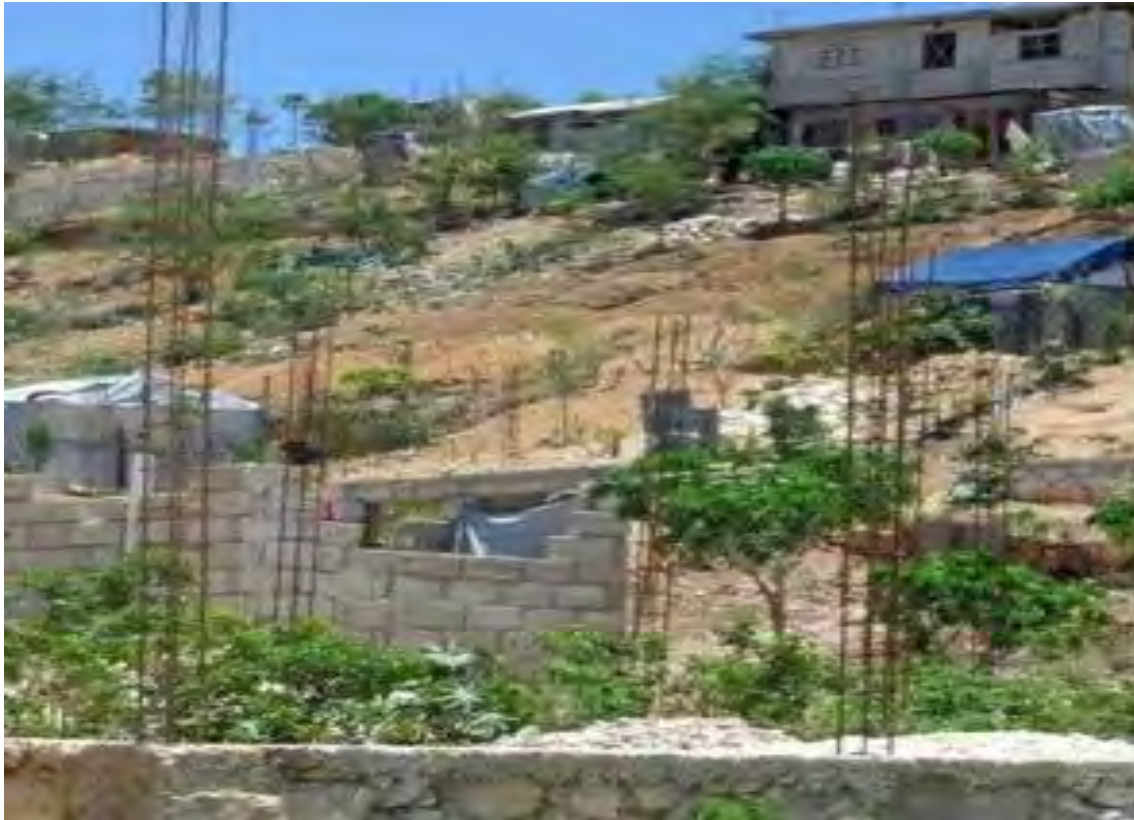
Figure 73 : Début de construction d'un habitat permanent
