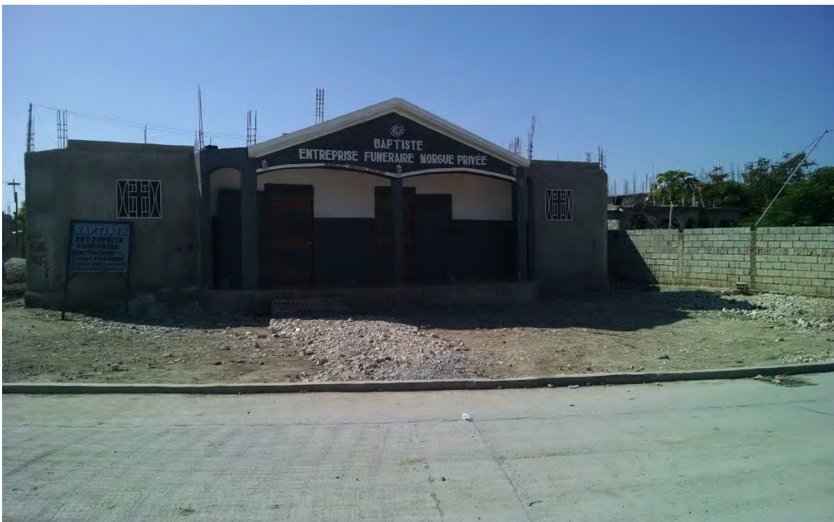
Figure 61 : Entreprise funéraire Baptiste dans le sous-quartier Canaan 3
