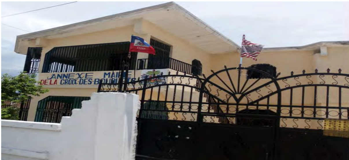
Figure 52 : Annexe principale de la mairie des Croix-des-Bouquets
