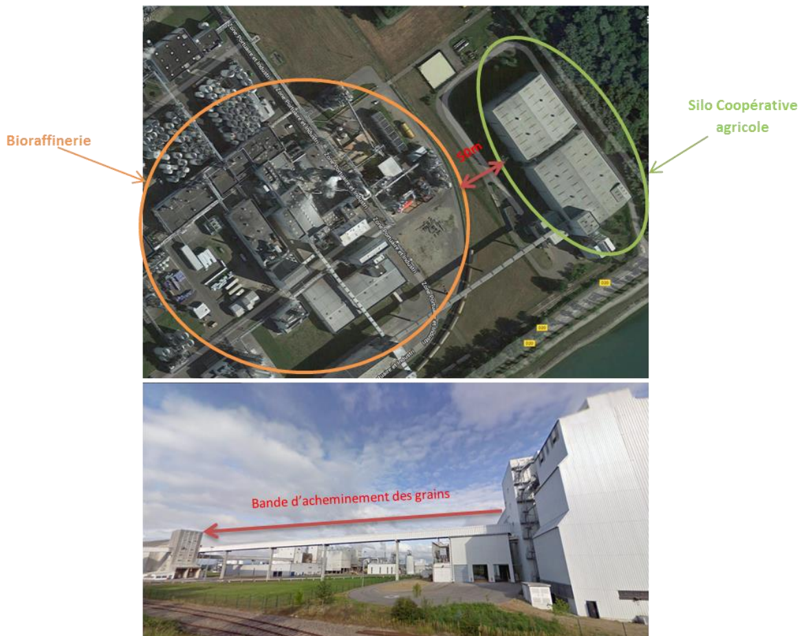
Figure 54 : Photos décrivant la distance entre la bioraffinerie et le silo de la coopérative agricole (Source : Google map)
