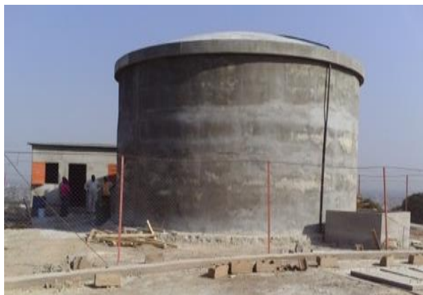
Photo 3 : Construction du château d'eau au quartier Eba'a
