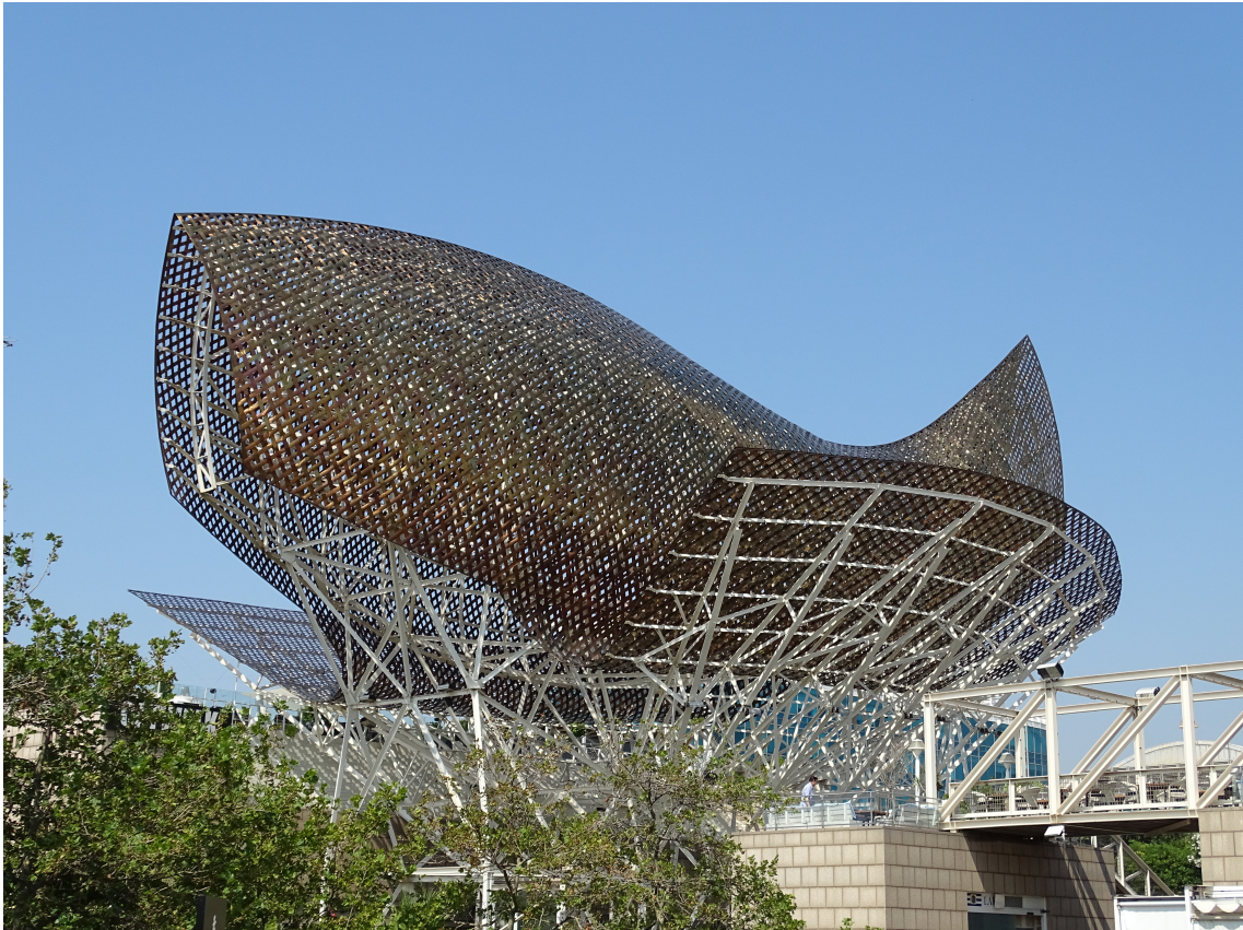
FIGURE 2.3 – Le Golden Fish à Barcelone (Frank Gehry) est le premier projet à avoir utilisé L'outil Digital Project, source : wikimedia.org, photo by Ad Meskens, Creative Commons by-sa
