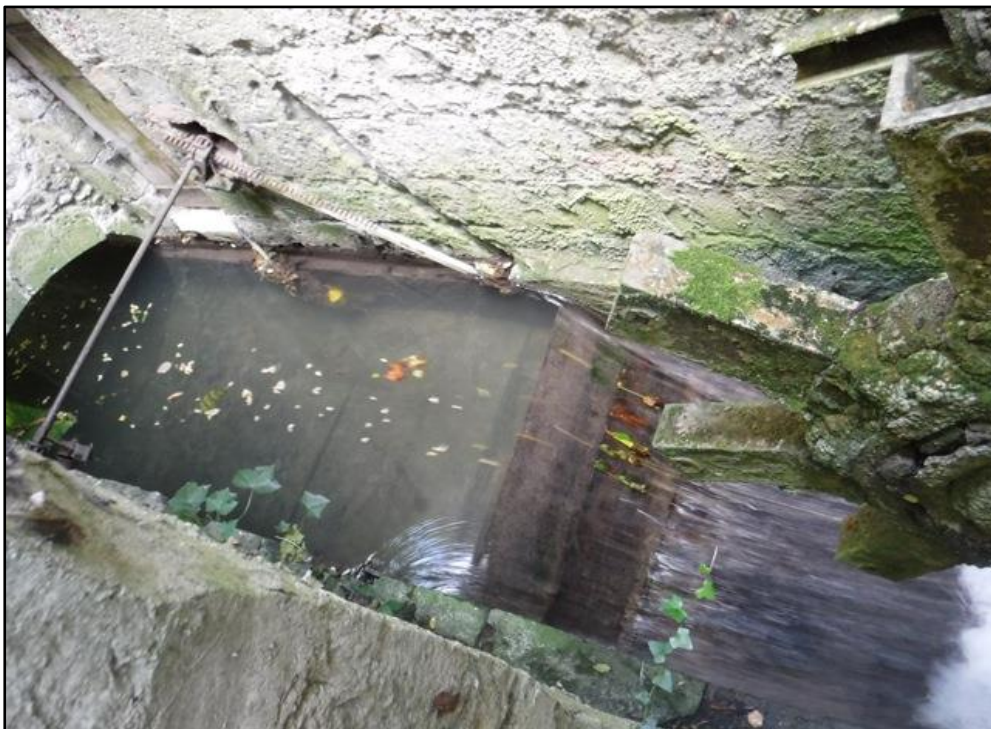
Figure 32 : L'ancienne vanne ouvrière du moulin de Saint-Hilaire, aujourd'hui bloquée sur le seuil en rivière principale. Dans la photo on voit également les anciens mécanismes qui permettaient de la manœuvrer et l'emplacement de la turbine (Source : Comm.de Comm. Terres du Val de Loire)
