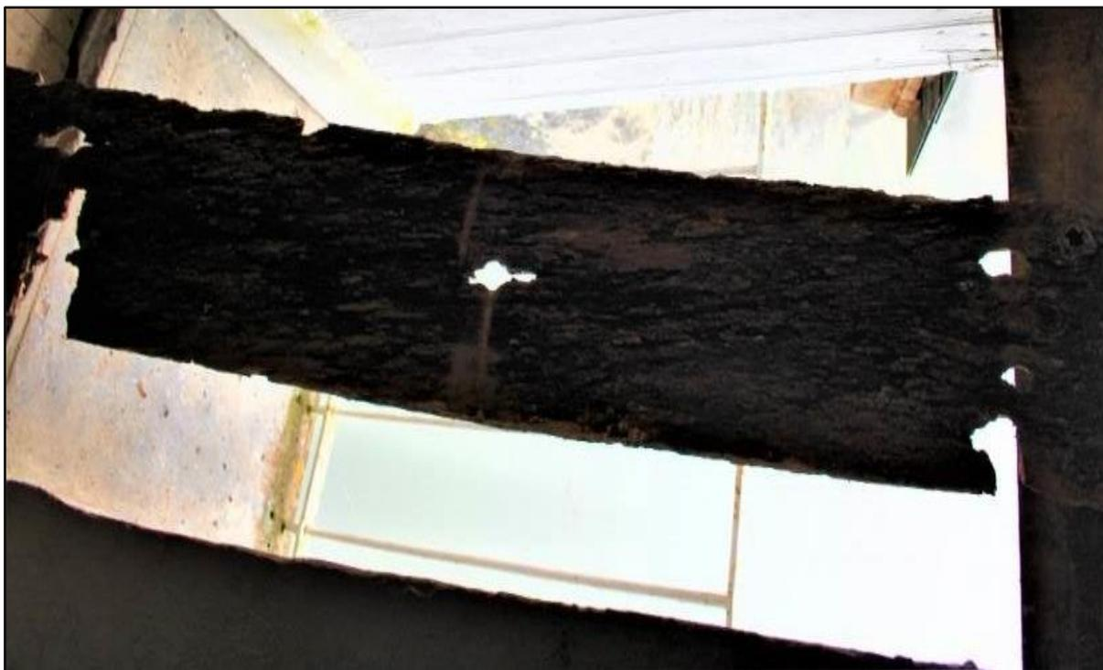
Figure 92 : L'état d'une ancienne planche de la roue du moulin de Thévalles (Photo réalisée par Francesco Donati).
