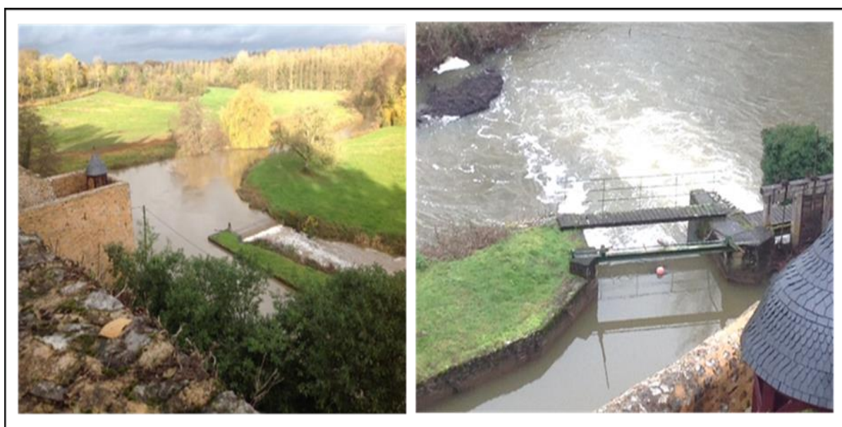
Figure 80 : À gauche : la crue qui a touché le terrain d'étude de Thévalles en décembre 2019. À droite : une des chaînes des thermomètres coincées dans les vannes ouvrières du moulin de Thévalles (Photos réalisées par P-H. de Vitton).
