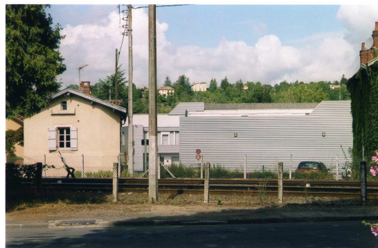
Photo n°44 : Sortie de l'usine
