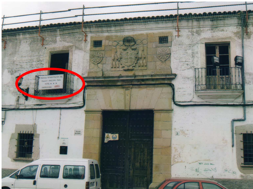
Photo n°58 : Le Palais Episcopal de Coria en cours de réhabilitation pour devenir un *** (cliché personnel, juin 2006).
