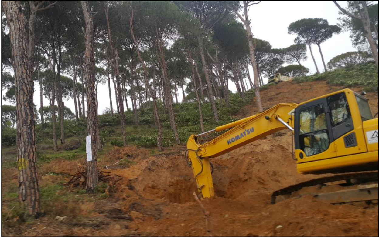
Photo 4 : Travaux d'excavation pour construire dans une forêt de pin à Qsaibé à 600 mètres d'altitude
