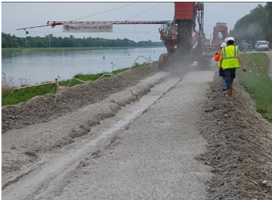
Figure II-9 : Equipement utilisé pour le Trenchmix® sur le chantier CS_3 et observation du matériau final obtenu
