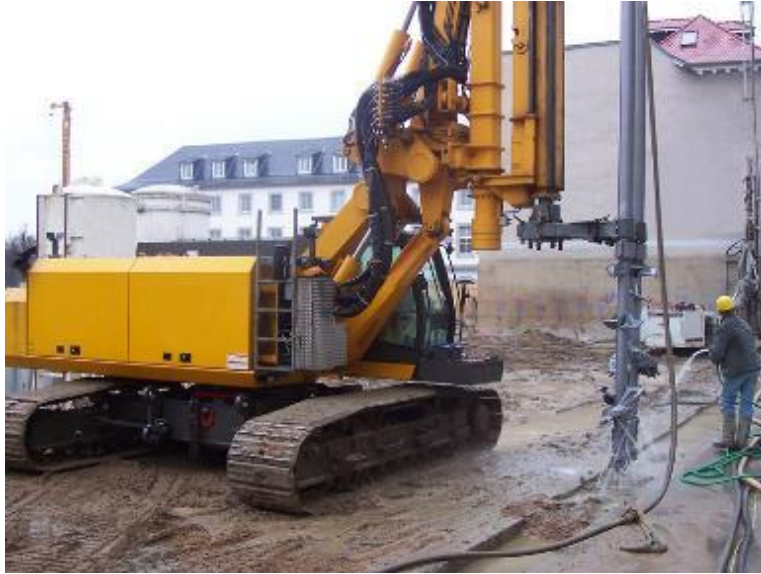
Figure II-1 : Equipement utilisé sur le chantier pour le Soil Mixing
