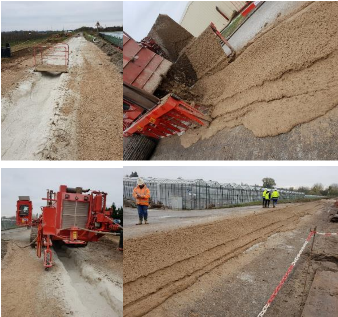
Figure II-8 : Trenchmix sur le chantier CS_2 ; équipement et réalisation
