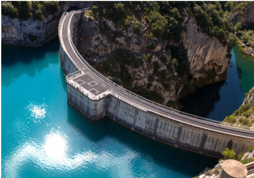
FIGURE 1.4 – Vue aérienne du barrage hydraulique et du lac de Sainte Croix dans les Gorges du Verdon. Photographie : Franck Oddoux - EDF.
