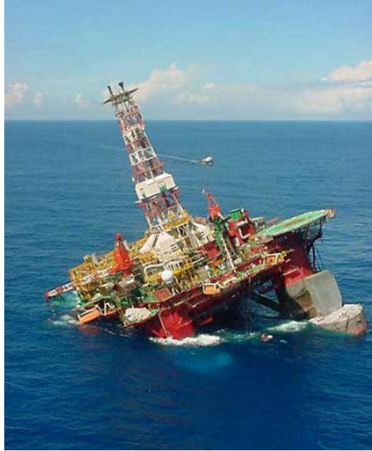
FIGURE 1.16 – Structure offshore détruite par des VIV.
