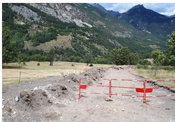
Enfouissement de ligne souterraine en prairie avant restauration Y. SINDZINGRE, 01/06/2020, Saint-Martin-de-Queyrières (05)
