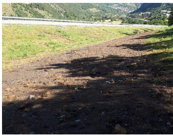
Tranchée refermée prête à l'ensemencement Y. SINDZINGRE, 01/06/2020, Saint-Martin-de-Queyrières (05)
