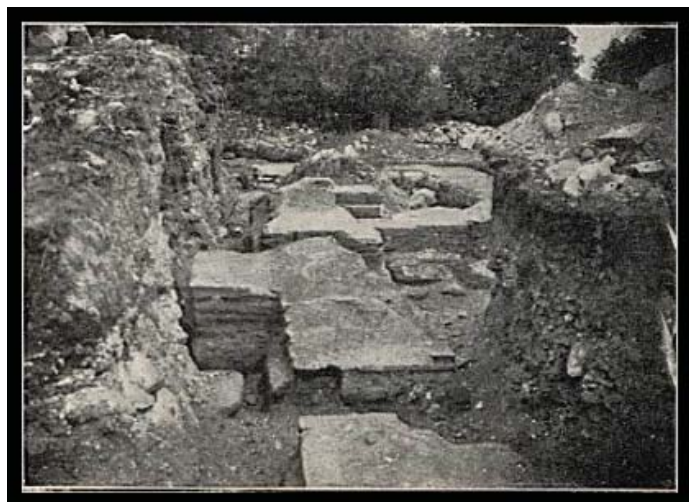
Fig. 3 Vue des maçonneries sud du narthex et des accès vers l'annexe sud. Cliché en NB de P. Mutafčiev, IBAI, 1915, fig. 65, p. 92.
