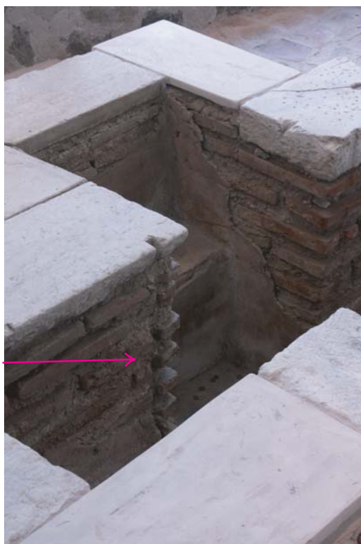
Fig. 3 Vue du bras nord de la cuve baptismale restaurée et de la rainure pour l'insertion de plaque de marbre.
