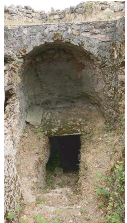
Fig. 7 Vue vers l'Est du 2 ème niveau inférieur.
