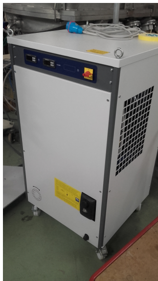
(a) Refroidisseur de FAZIA relié via les souterrains à la clarinette dans la salle d'expérience D5
