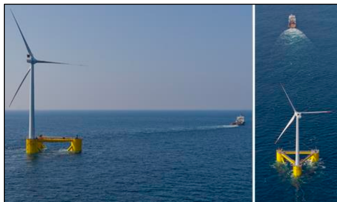
Figure 10 : Première éolienne flottante au Portugal – projet Windfloat (2012)
