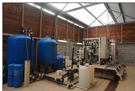
Figure 47 : À gauche le dessalinisateur d'eau de mer sur l'île de Sein. À droite l'impluvium, récupérateur d'eau de pluie sur l'île de Molène. Source : M. T. juillet 2017, mai 2016
