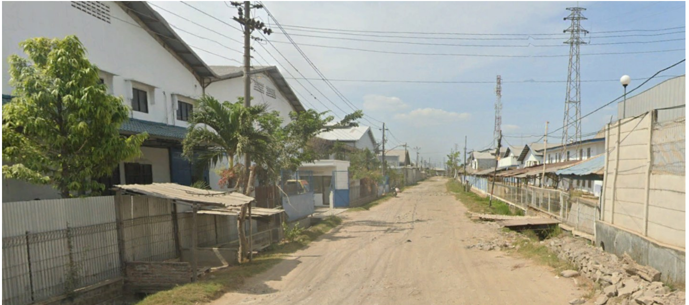
Photo 54 : Dans les zones industrielles, des infrastructures très dégradées : état en août 2019 d'une des voies secondaire (Jl. Industri barat I) autrefois asphaltée à KIT
