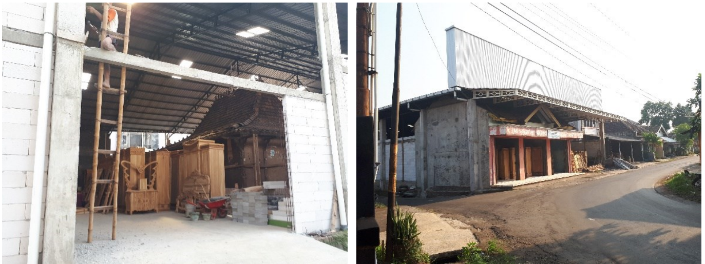
Photo 27 : Construction d'un entrepôt par-dessus une maison traditionnelle (encore habitée par la mère de l'entrepreneur) (11A)
