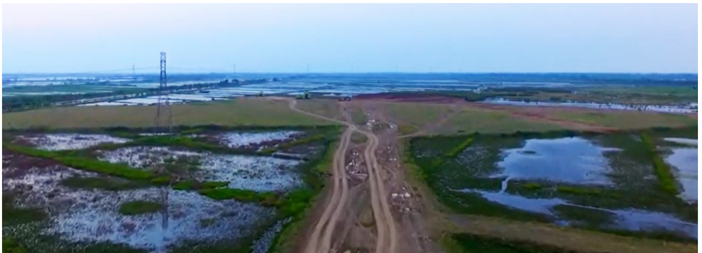
Photo 52 : Travaux d'aménagement sur les mangroves de Jatengland Industrial Park Sayung
