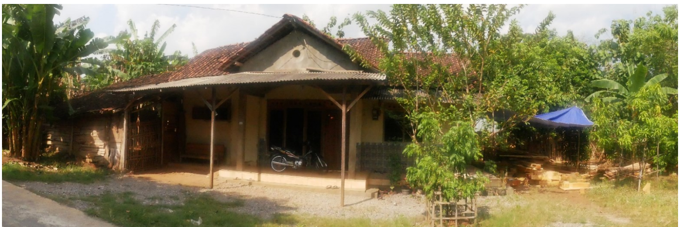
Photo 26 : Aménagements de fortune accompagnant l'extension de l'activité chez un artisan de Tahunan (07D) : atelier en murs de planches, auvent en tôle ondulée (au centre), et tente en plastique (à droite)
