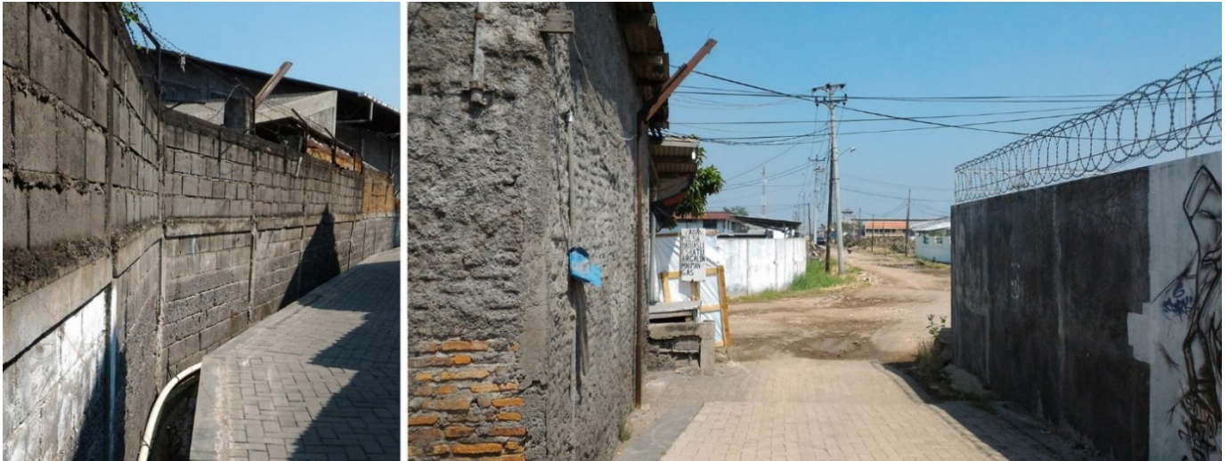
Photo 43 : Mur séparant le quartier de la zone industrielle de KI Terminal le long de Jl. 05 (à gauche) et entrée de la zone industrielle au débouché ouest de Jl. 06
