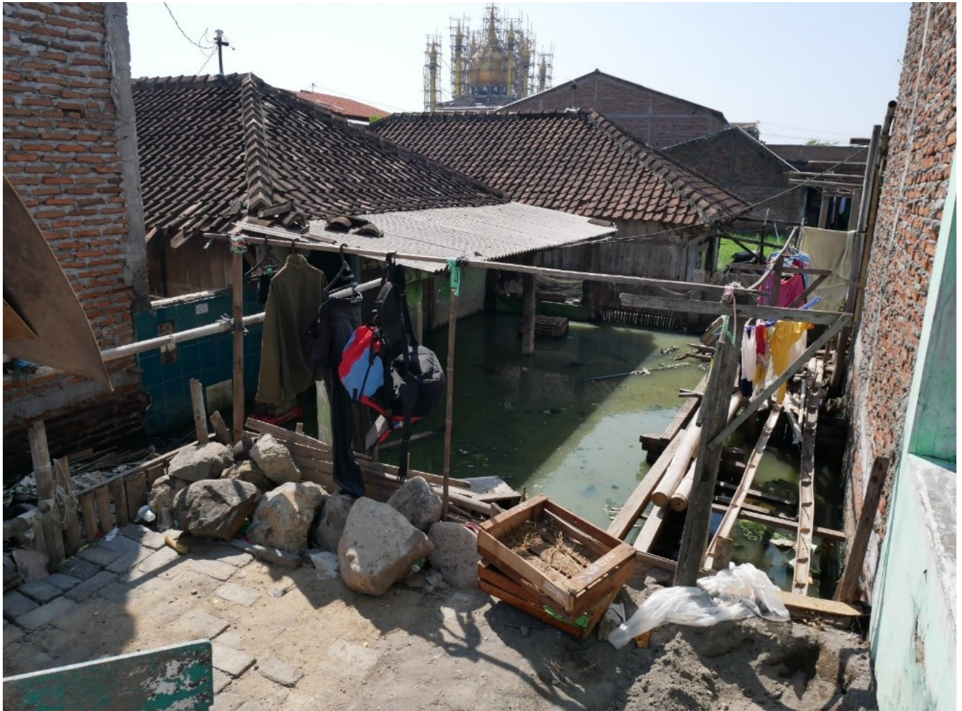
Photo 40 : Rob*, maisons affaissées (aux 2 ème et 3 ème plans) et surélévation en cours de la terrasse de la maison 01A
