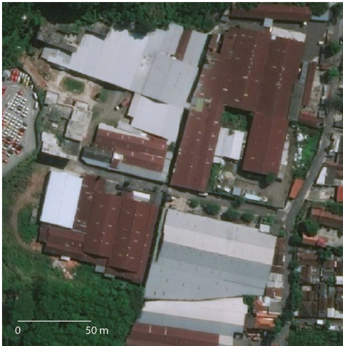
Photo 35 : Enchevêtrement des bâtiments industriels et de leurs extensions à Bangkongsari (à gauche) et atelier de meubles de Bpk Giri (06E) (à droite)
