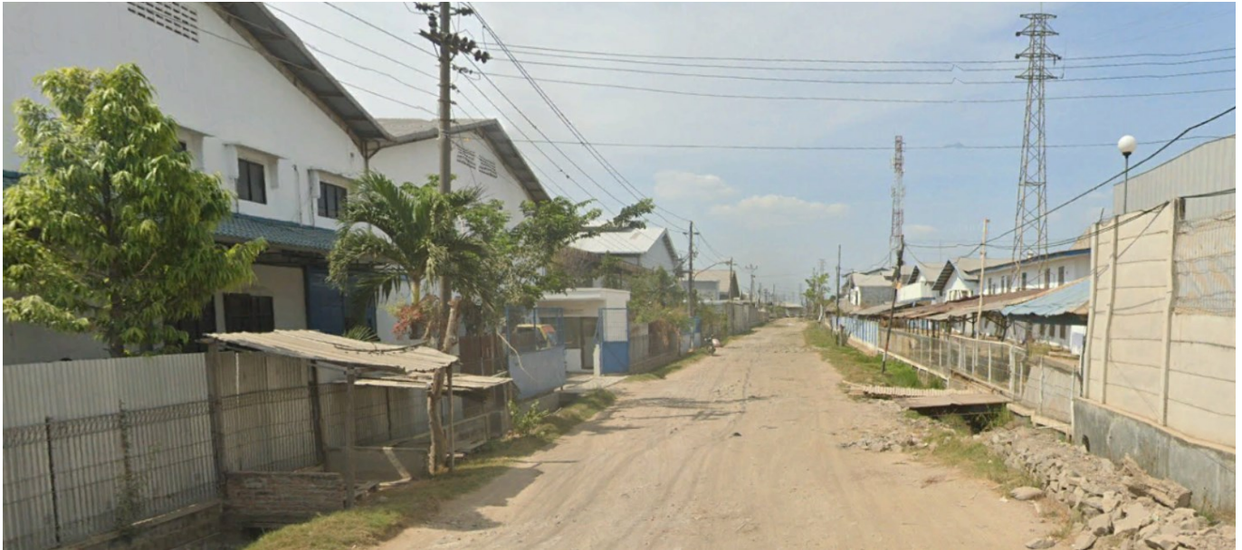
Photo 54 : Dans les zones industrielles, des infrastructures très dégradées : état en août 2019 d'une des voies secondaire (Jl. Industri barat I) autrefois asphaltée à KIT
