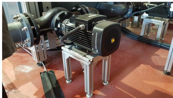
FIGURE 3.22 – Une pompe et son support. Le support permet de bloquer le mouvement de balourd de la pompe.
