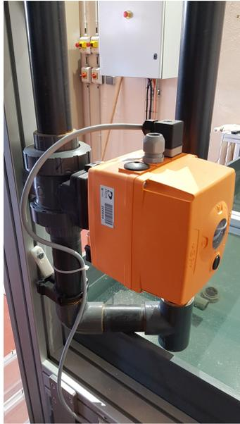
FIGURE 3.26 – Photo de la vanne pilotée installée sur la ligne de fuite entre les réservoirs supérieur et inférieur.
