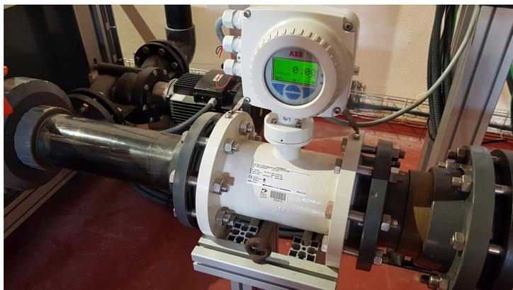
FIGURE 3.16 – Photo du débitmètre installé sur la ligne de retour au réservoir inférieur.
