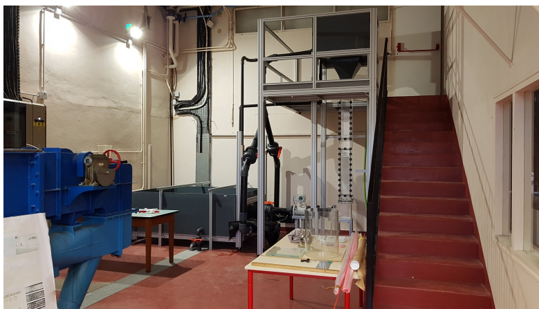
FIGURE 3.1 – Photo de la zone d'installation de la boucle hydraulique.
