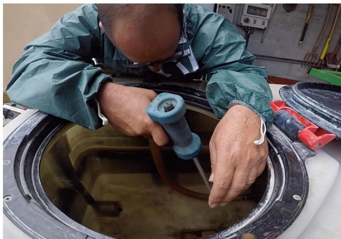
Illustration 67 : Rinçage de la cuve intermédiaire. E1, 17 juillet 2018.
