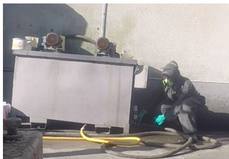
Illustration 95 : Raccord de la cuve intermédiaire.
