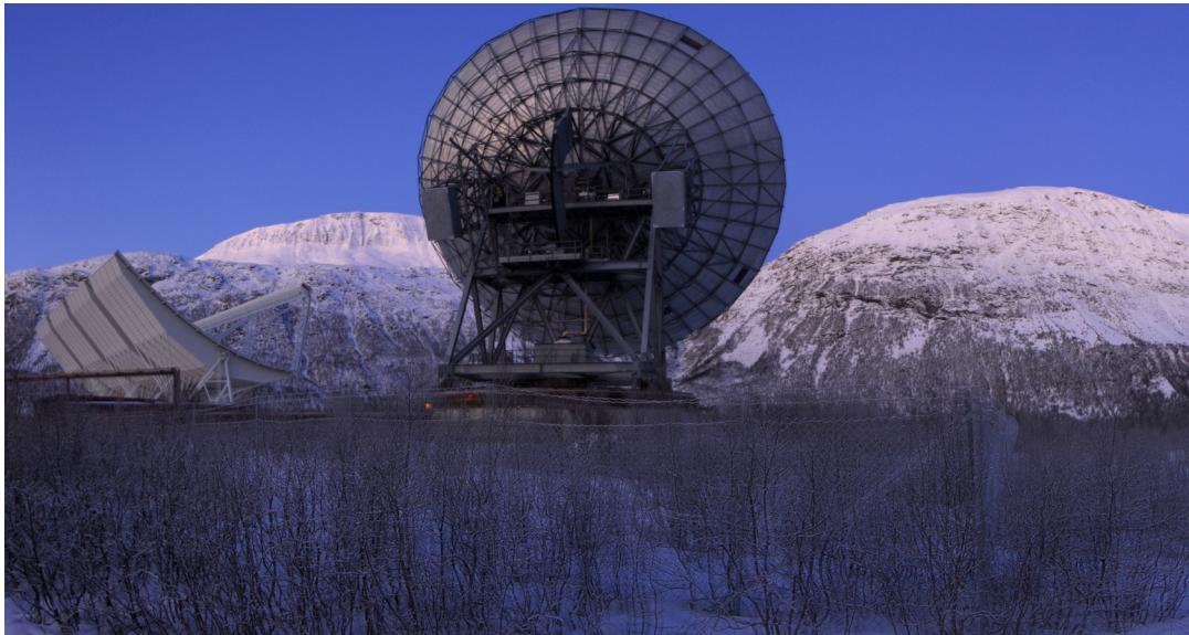
FIGURE 1.5 – Photographie de l'antenne VHF (à gauche) et UHF (à droite) d'EISCAT proche de Tromsø. Nous utiliserons ses données au cours de ce travail. Attention, la perspective est trompeuse : l'antenne VHF est bien plus imposante ( $124 \times 40$  m) que l'UHF (32 m “seulement”) ! (crédit photo : Cyril Simon Wedlund)
