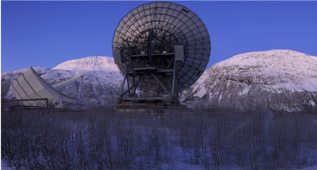
FIGURE 1.5 – Photographie de l'antenne VHF (à gauche) et UHF (à droite) d'EISCAT proche de Tromsø. Nous utiliserons ses données au cours de ce travail. Attention, la perspective est trompeuse : l'antenne VHF est bien plus imposante ( 124 \times 40 m) que l'UHF (32 m "seulement")! (crédit photo : Cyril Simon Wedlund)
