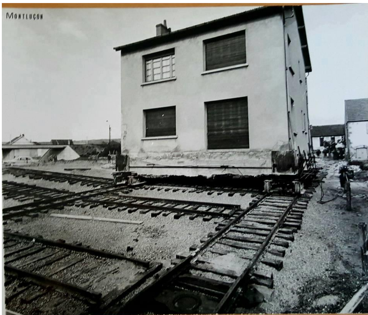
Image 39: Déplacement d'une maison pour éviter sa démolition lors de l'aménagement de la rocade
