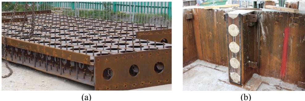
Figure 1-3 (a) Modules de plancher en « Steel Brick » ; (b) Module de voile « Steel Brick » avec béton (Burgan & Bingham, 2017)
