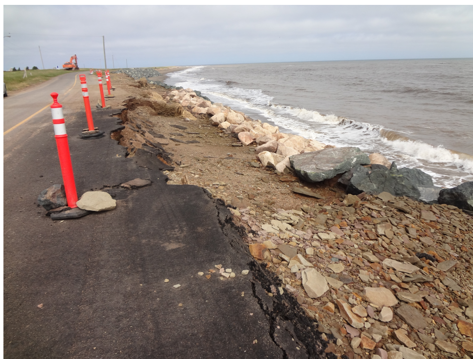
Photo 6 : Impact de l'érosion sur une route côtière provinciale, Nouveau-Brunswick, Canada. M. Noblet, 2012.
