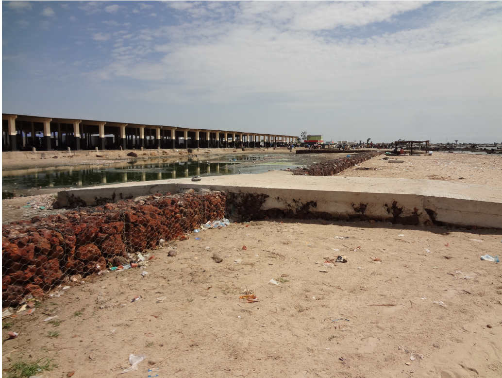
Photo 1 : La digue de protection du quai de pêche et l'eau stagnante entre la digue et le quai, Joal-Fadiouth. M. Noblet, 2012.
