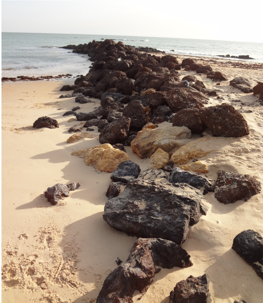
Photo 4. Un brise lame installé par un hôtelier de Saly, Sénégal. M. Noblet, 2012.
