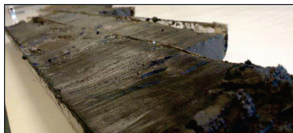
Figure 27: Photo de la carotte prélevée à l'aval du bassin versant à Arles. Source: IRSN
