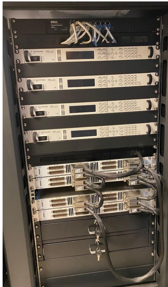
Figure IV. 36: Banc de pilotage et d'alimentation DC multivoies.
