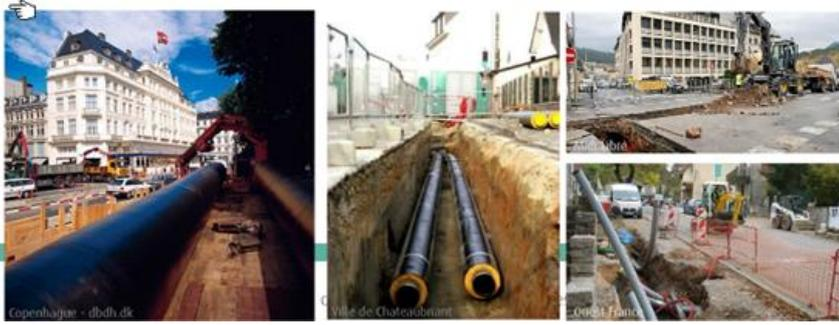
FIGURE 2.1 Conduites enterrées des réseaux de chaleur
