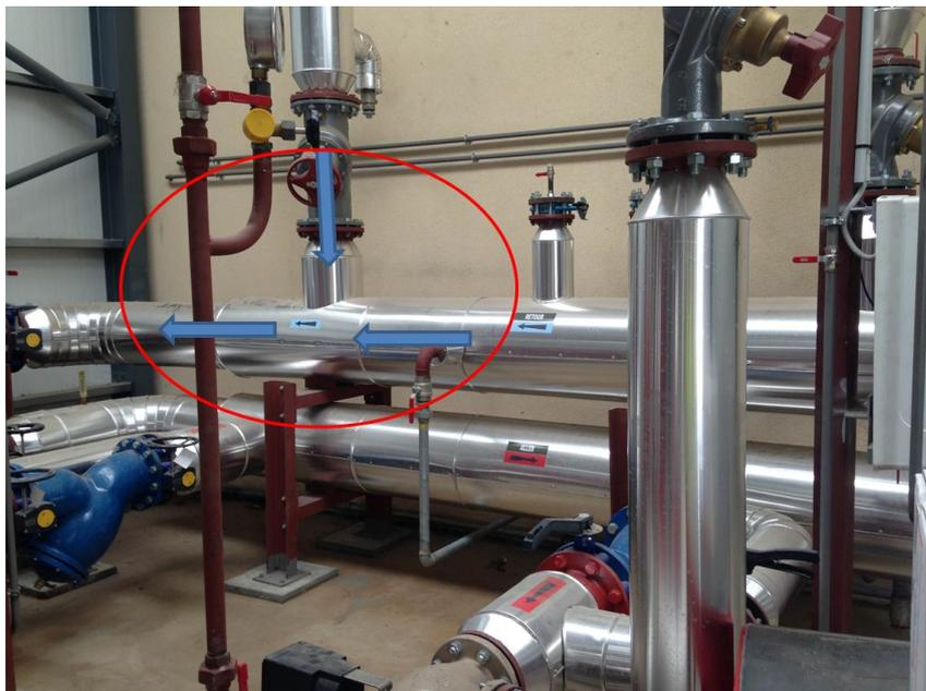
FIGURE 2.3 Exemple d'une conduite à 2 entrées et 1 sortie
