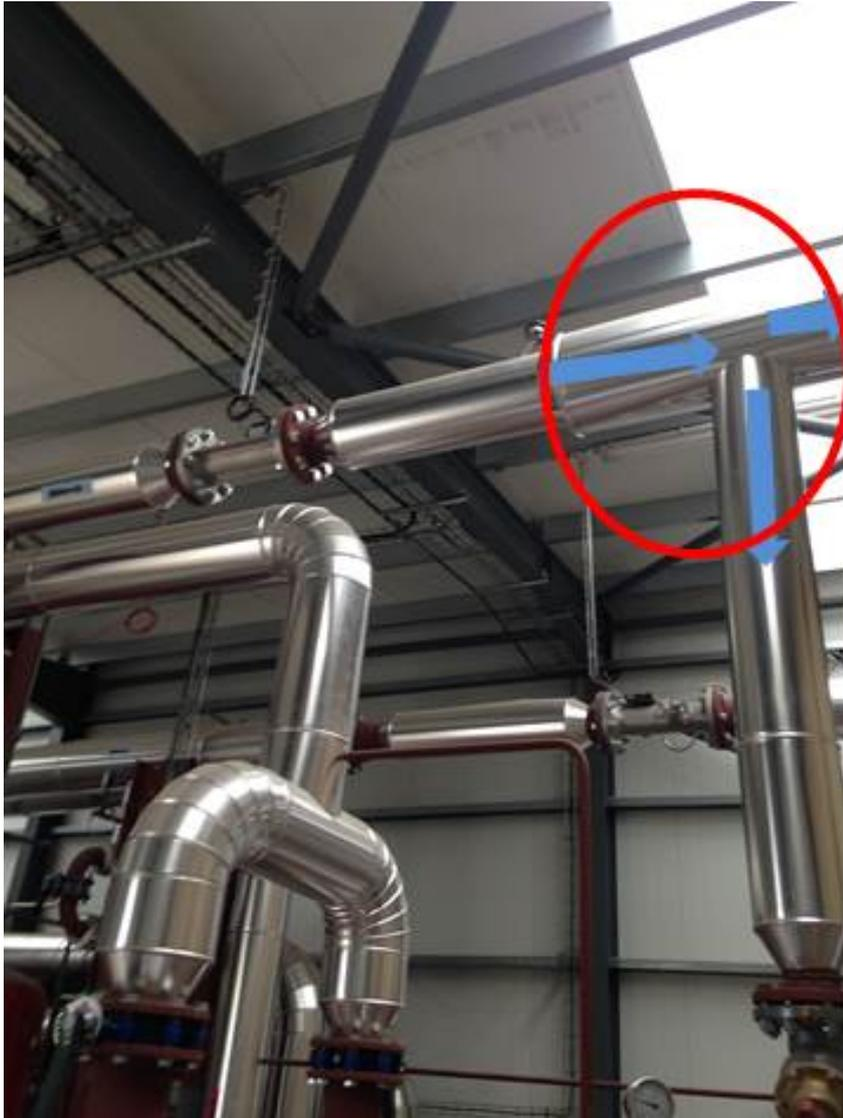
FIGURE 2.4 Exemple d'une conduite à 1 entrée et 2 sorties
