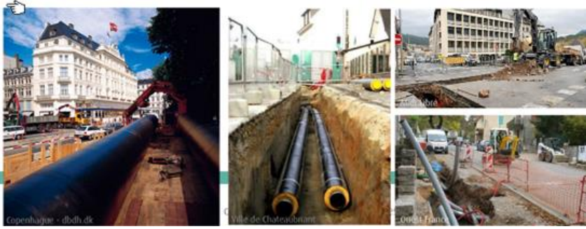
FIGURE 2.1 Conduites enterrées des réseaux de chaleur
