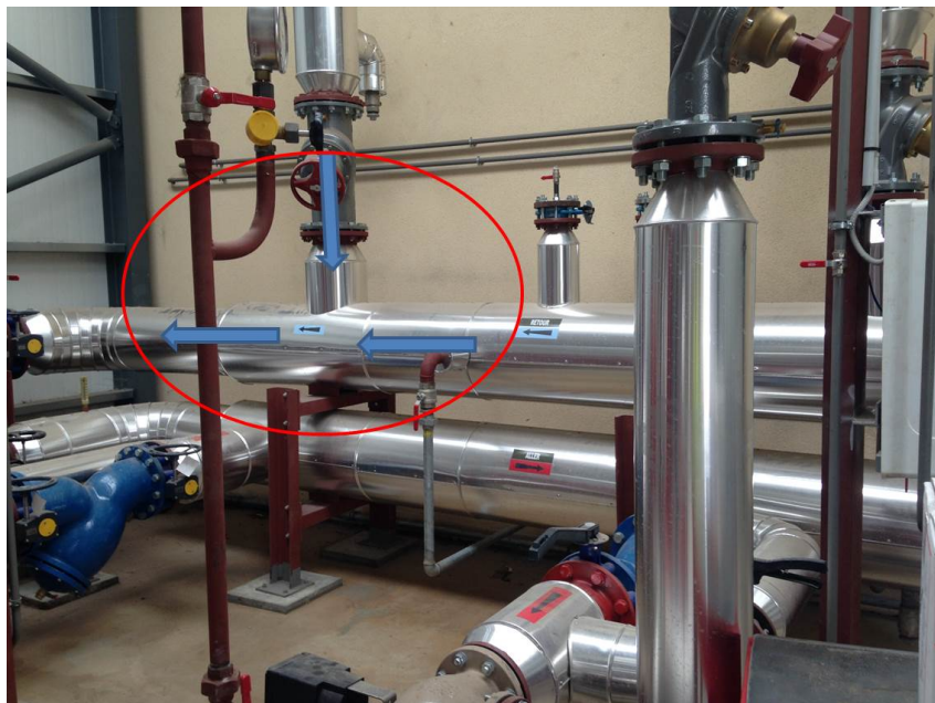
FIGURE 2.3 Exemple d'une conduite à 2 entrées et 1 sortie
