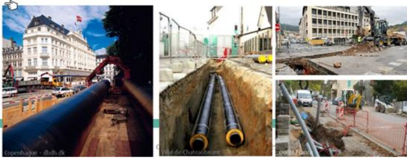
FIGURE 2.1 Conduites enterrées des réseaux de chaleur
