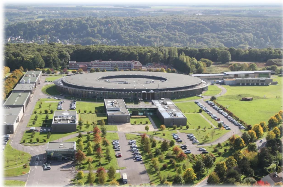
Figure 96 : Photographie du synchrotron SOLEIL
