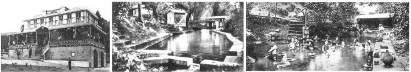
Figure 24 : Ancien site thermal de Dolé-les-Bains, à Gourbeyre en Guadeloupe (archives de l'embouteilleur Capes Dolé)
