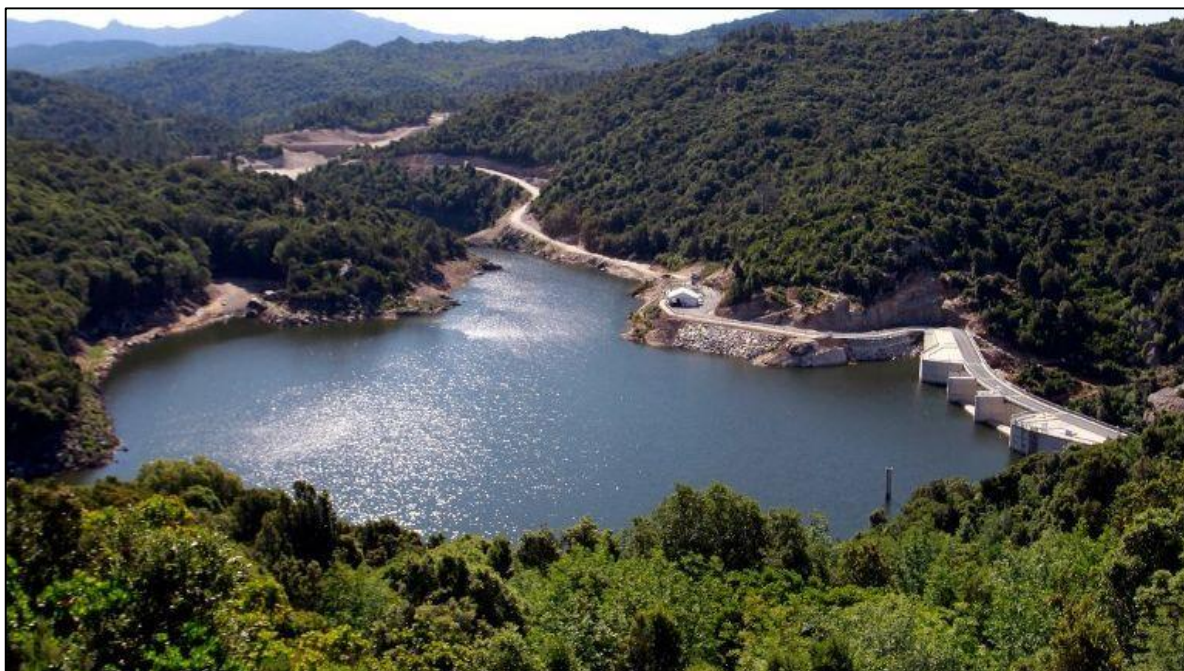
Figure 2 : La retenue de barrage du Rizzanese (Crédit photo : © 2019 EDF)
