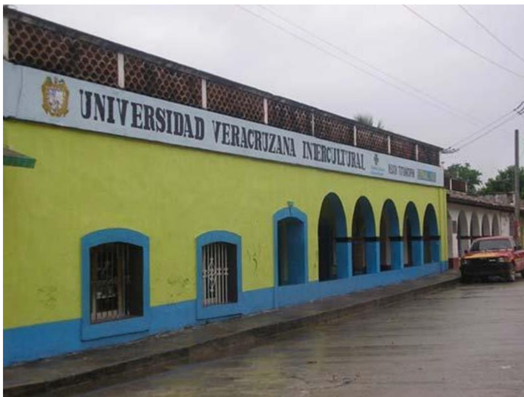
Figure 15. Façade de l'UVI-T située dans les installations de la Casa de la Cultura d'Espinal
