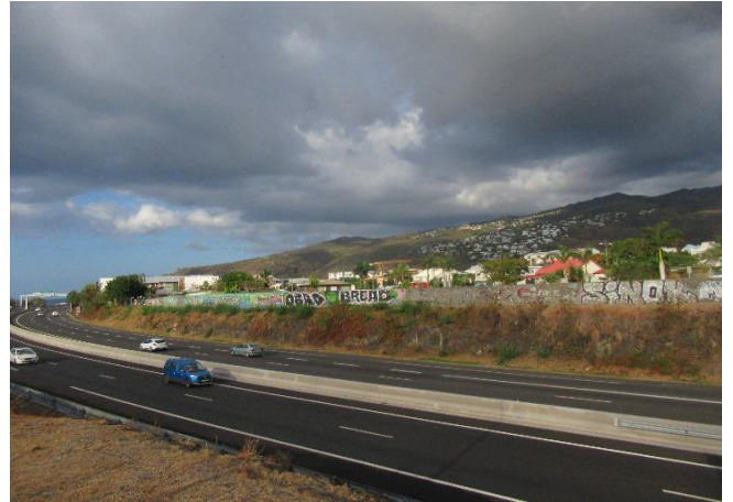
Photo 25. La route du Littoral traversant la commune de La Possession. Crédit : Begue, 2020
