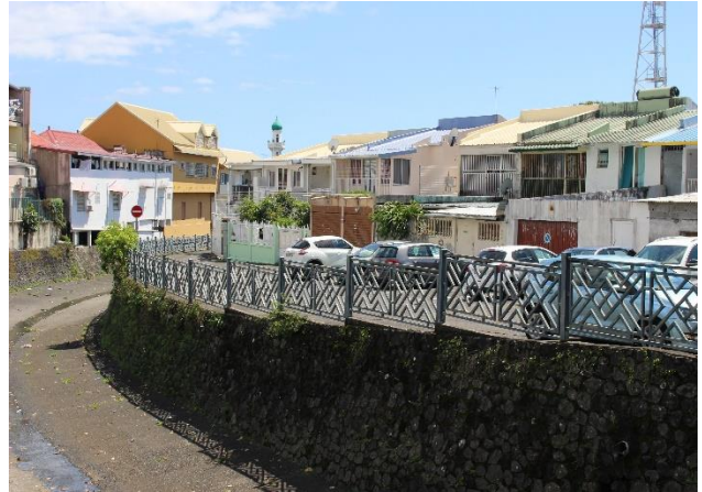
Photo 37. Ravine sèche traversant le centre-ville de Saint-André. Crédit : Longépée, 2019
