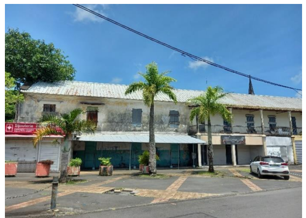
Photo 39. Ancienne école des Frères (centre-ville de Saint-André) Crédit : Begue, 2021.
