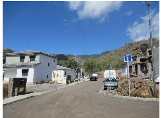
Photo 61. Maisons en construction à proximité de Cœur de Ville.
