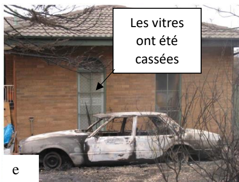
Figure 1. 9: a) Les braises ont enflammé le grenier [162], b) Goutières fondues [162], c) Allumage d'un plancher suspendu à cause des matériaux combustibles présents autour et sur le plancher [162], d) Propagation du feu à la maison par les escaliers et les poutres en bois [162], e) Chaleur rayonnante due un incendie de voiture [154] et f) Attaque de brandon sur une chaise [154]
