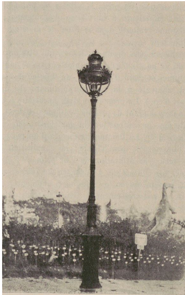
Figure 63 - Dispositif d'éclairage au gaz surpressé présenté à l'Exposition Universelle de 1900. R. Boutteville (1925).
