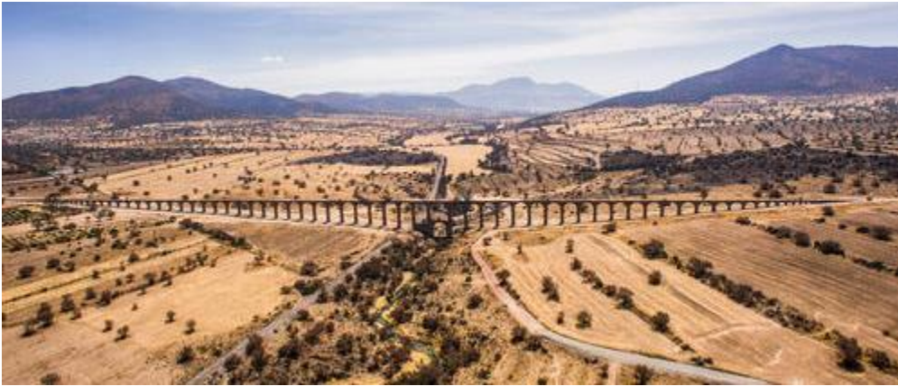
Figure 43 Aqueduc du Prêtre Tembleque, Otumba, Mexique.
