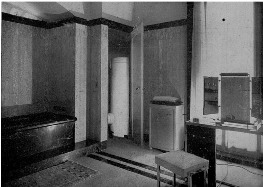
Figure 181 : Salle de bain avec chauffe-eau électrique à accumulation, in l'Architecture d'aujourd'hui , n° 3, 1932, p. 115.
