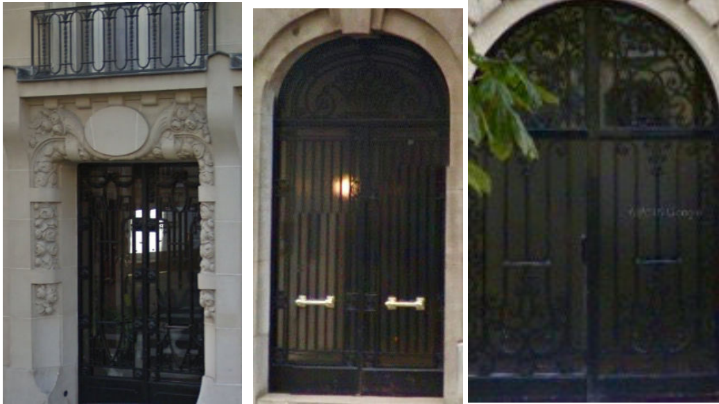
Figure 157 : Jean Boucher et René Pierre, 12 square de Clignancourt 18 e , 1924, Éclectisme post-haussmannien, couronne végétale, cliché GM.
