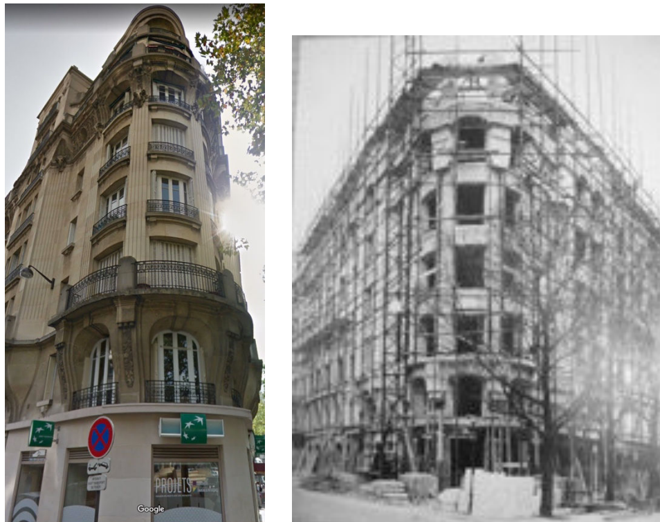
Figure 214 : Jacques-Maurice Boutterin, 9 place Félix Éboué 12 e , 1925, Éclectisme post-haussmannien, cliché GM., photo de chantier in AA 20 e : BOUTT-D-20-1, 272 AA 1/13.
