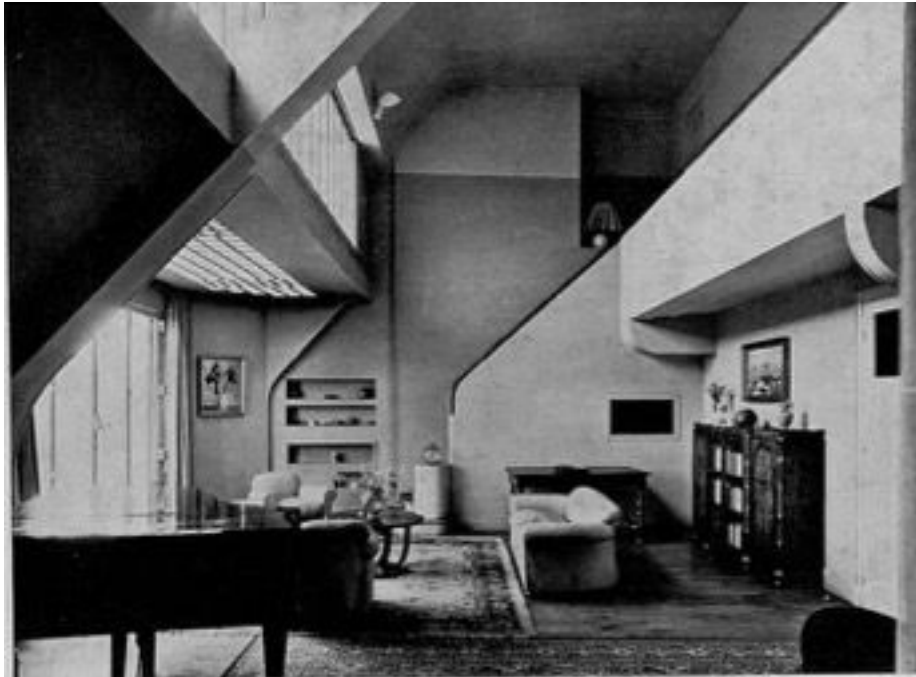
Figure 227 : Édouard Malot, 102 rue d'Assas 6è, 1934, Innovation tempérée, intérieur d'un studio, in l'Architecture d'Aujourd'hui , n° 7, septembre 1934, pp. 36-37 clichés Salaün.
