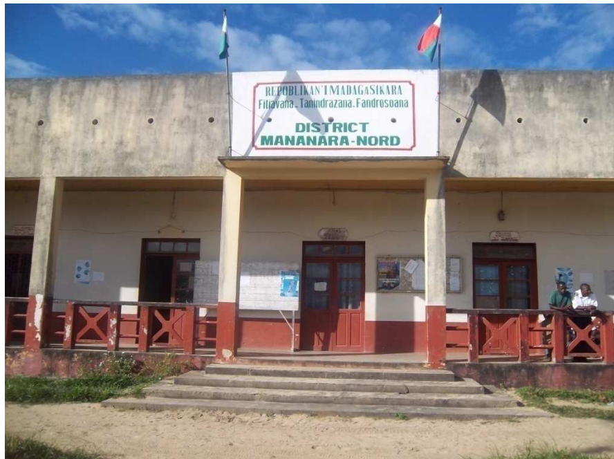
Photo 4 : Le bâtiment de district de Mananara Nord, construit en 1929, rénové plus de 10 fois, photo prise en Juin 2012.
