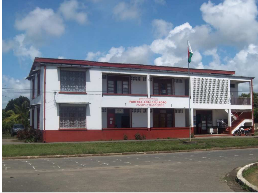
Photo 3 : Le bâtiment de la Région Analanjirofo daté de la 1940 rénové six fois depuis 1975, le rez-de-chaussée est occupé par le personnel de district de Fenérive-Est et l'étage appartient au chef de région et son équipe, photo prise en Juin 2012
