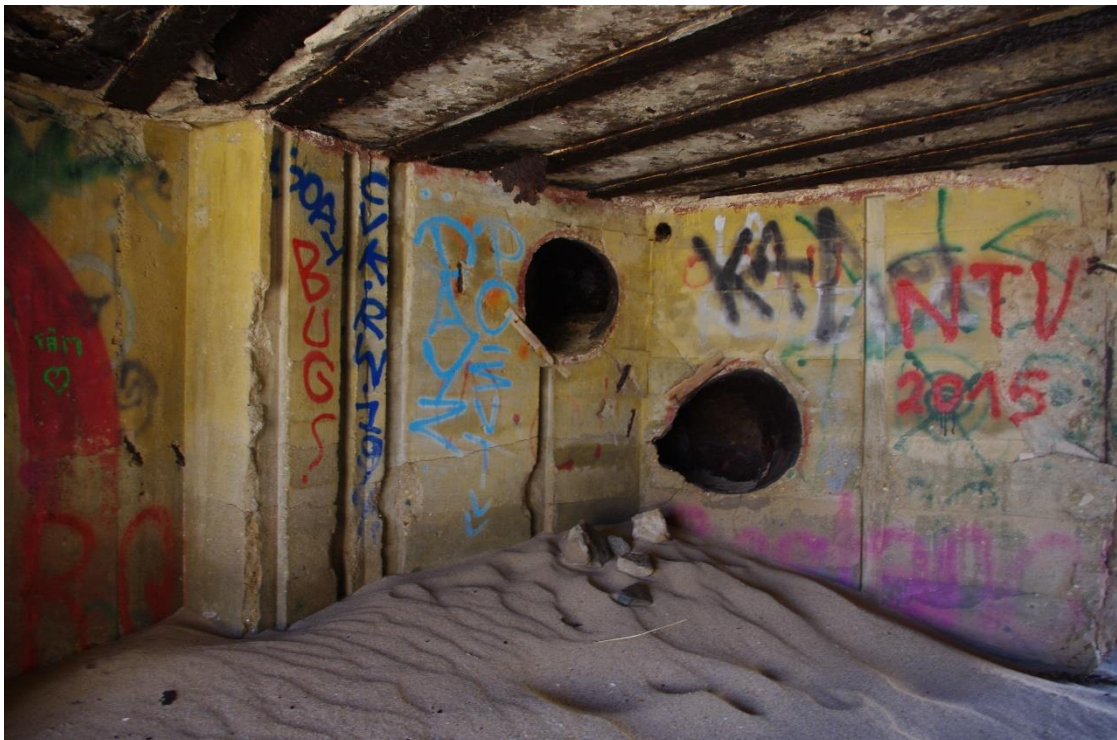
Photographie des tubulures garantissant au blockhaus l'extraction des gaz issues du canon. Point d'appui Sa115. ©Graffard T.
