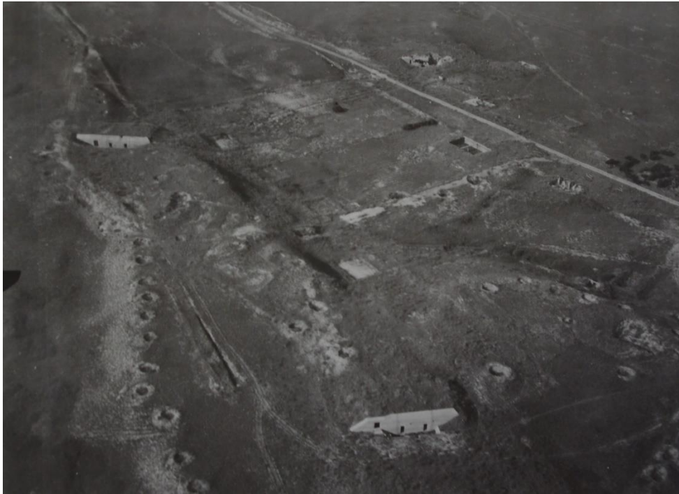
SHD – Rochefort, cote 1 W 1848. Vue aérienne des abris « passifs », position Sa115, Noirmoutier.
