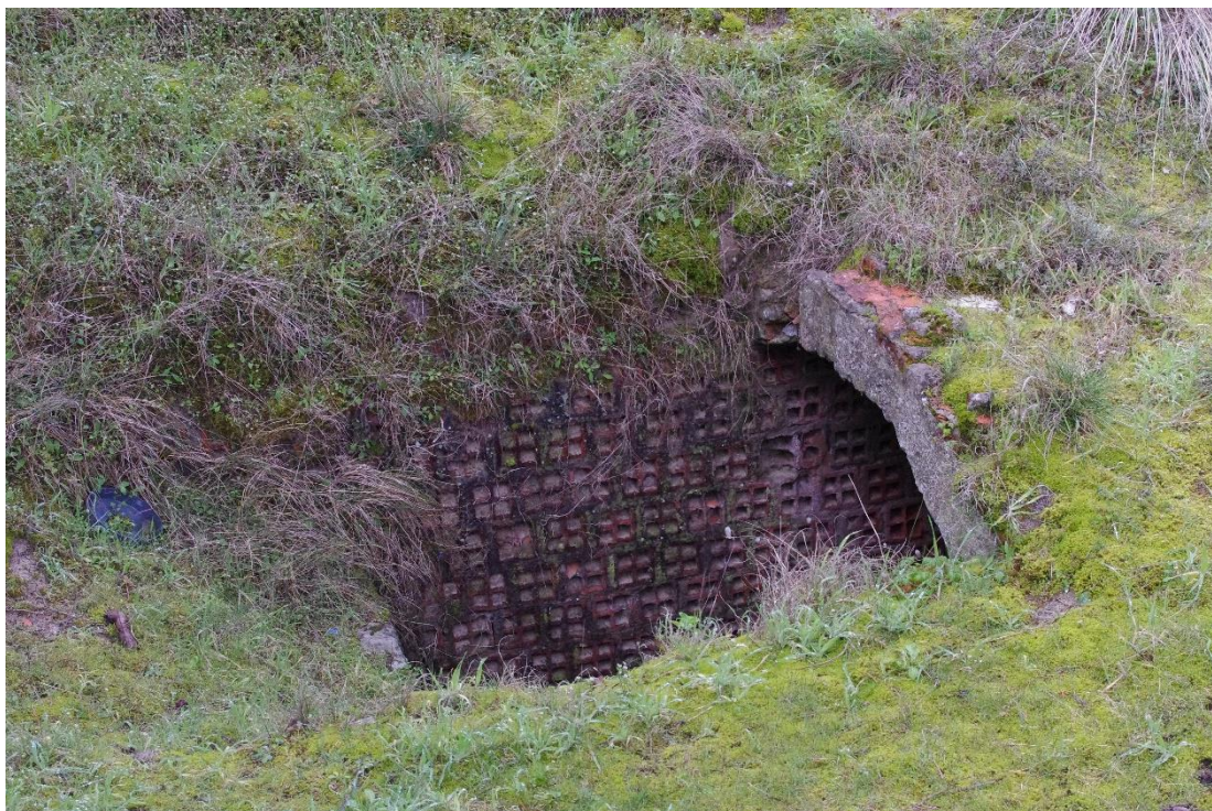
L'unique entrée de la soute à munitions, position Sa109. À noter la particularité de ces briques que l'on retrouve en grande quantité sur l'île de Noirmoutier. ©Graffard T.
