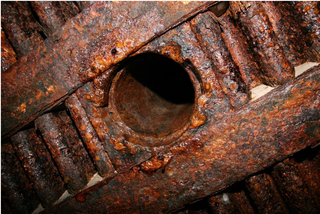
Tube blindé type 735P3 pour périscope SR9 ou SR10. À noter les deux encoches permettant le verrouillage de l'obturateur. Crédits : Institut Villa Notre Dame.
