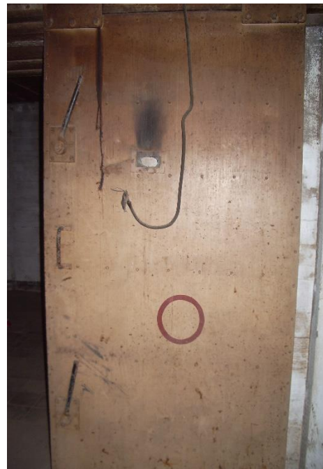
Photographie d'une porte blindée 26P8. À noter le cercle rouge signifiant qu'il s'agit d'une porte étanche. ©Graffard T.
