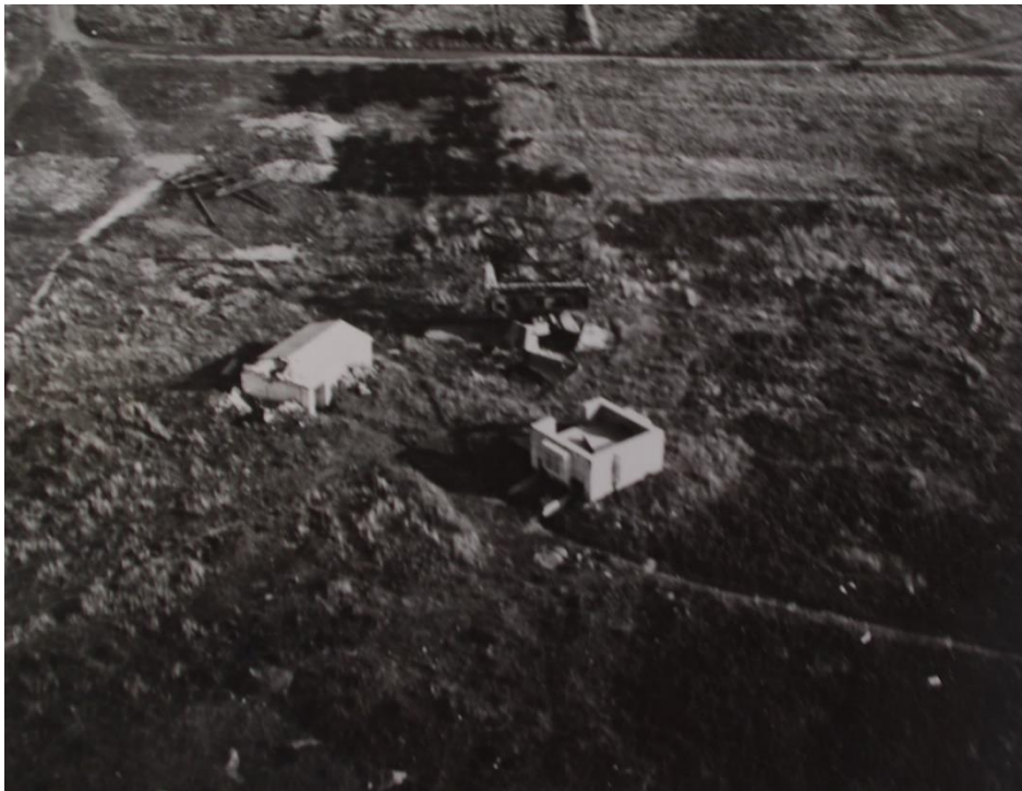
SHD – Rochefort, cote 1 W 1848. Vue d'ensemble, avec l'encuvement pour DCA, le tobrouk et le radar Würzburg Riese.
