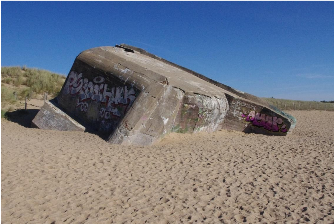
Photographie du modèle R612 situé sur la plage de Sion, point d'appui Sa09. À noter le mur de flanquement assez conséquent. ©Graffard T.
