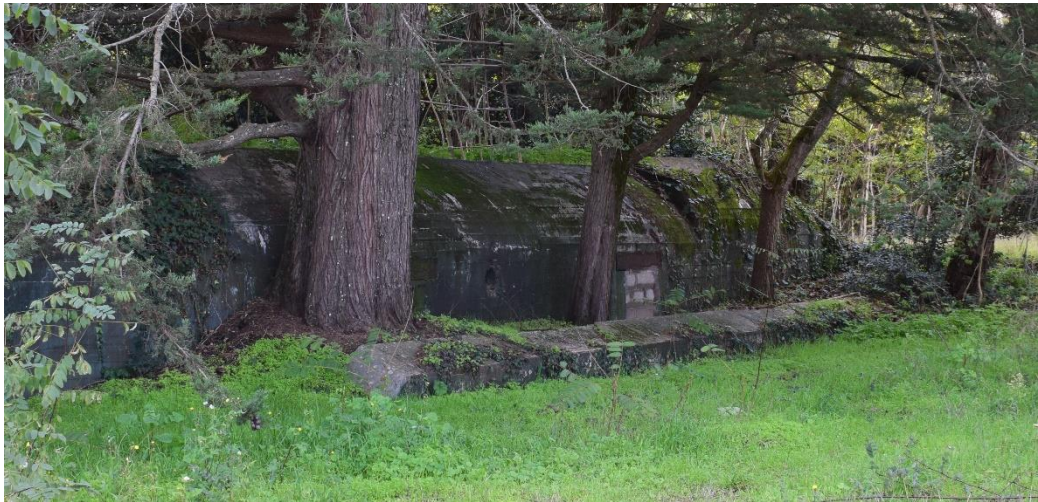
Illustration 29. Une tranchée « hors-norme ». Sa70 les Sables-d'Olonne.
