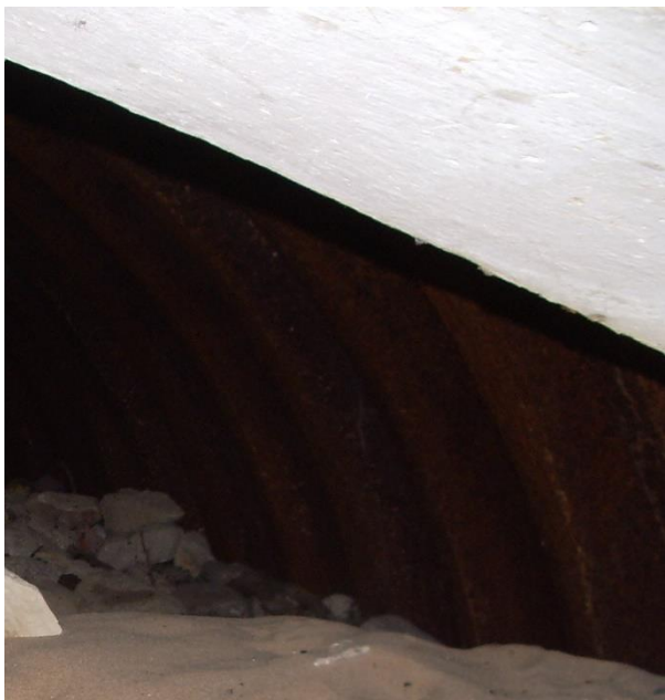
À l'intérieur du Vf 1b de la position Sa85, où la tôle métro est encore apparante. ©Graffard T.
