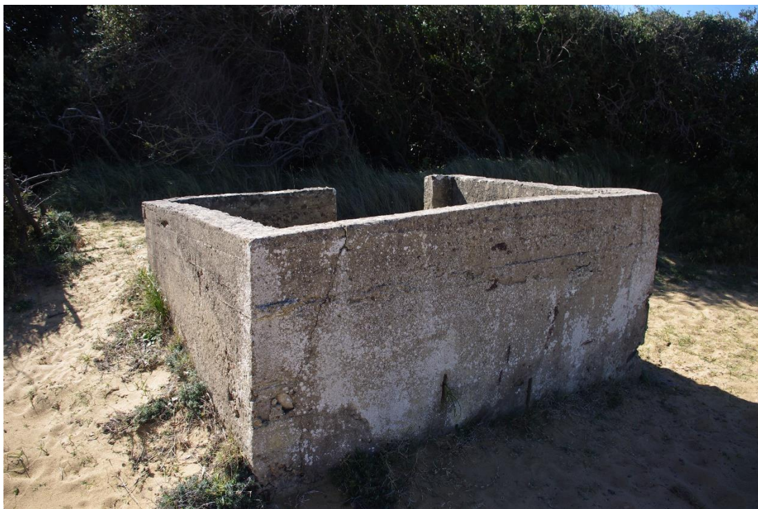
Photographie d'une soute à munitions en béton coffré à la pointe du Payré (Sa77). ©Graffard T.
