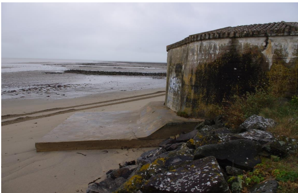
Photographie d'une casemate R669 avec une plaque de rupture horizontale installée à la batterie Tirpitz à la Guérinière (Sa114). ©Graffard T.
