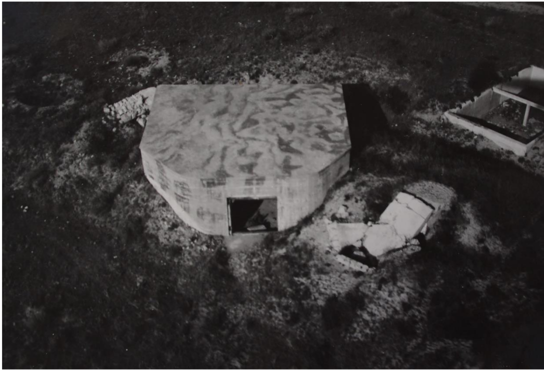
SHD – Rochefort, cote 1 W 1848. Casemate R669 recouverte d'un camouflage en « vague » à la batterie Tirpitz à Noirmoutier.
