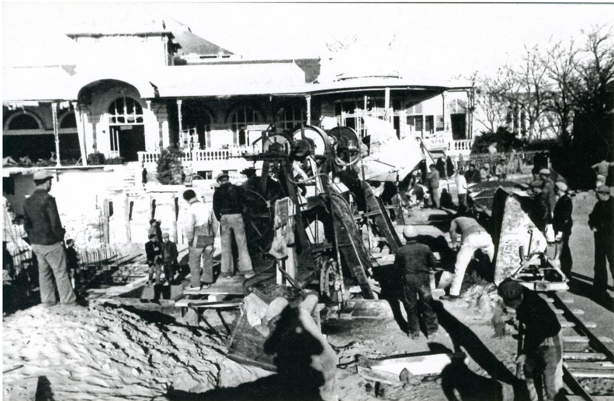
AMSO, cote 16Fi. Photographie de la construction d'un des R611 devant le casino du Remblai aux Sables-d'Olonne.
