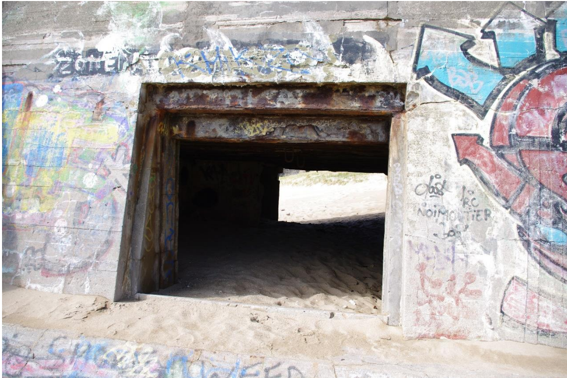
Photographie actuelle du R612 position Sa115. On remarque distinctement les deux créneaux du linteau de l'embrasure pour l'installation d'un 10,5 cm le.F.H.16. ©Graffard T.
