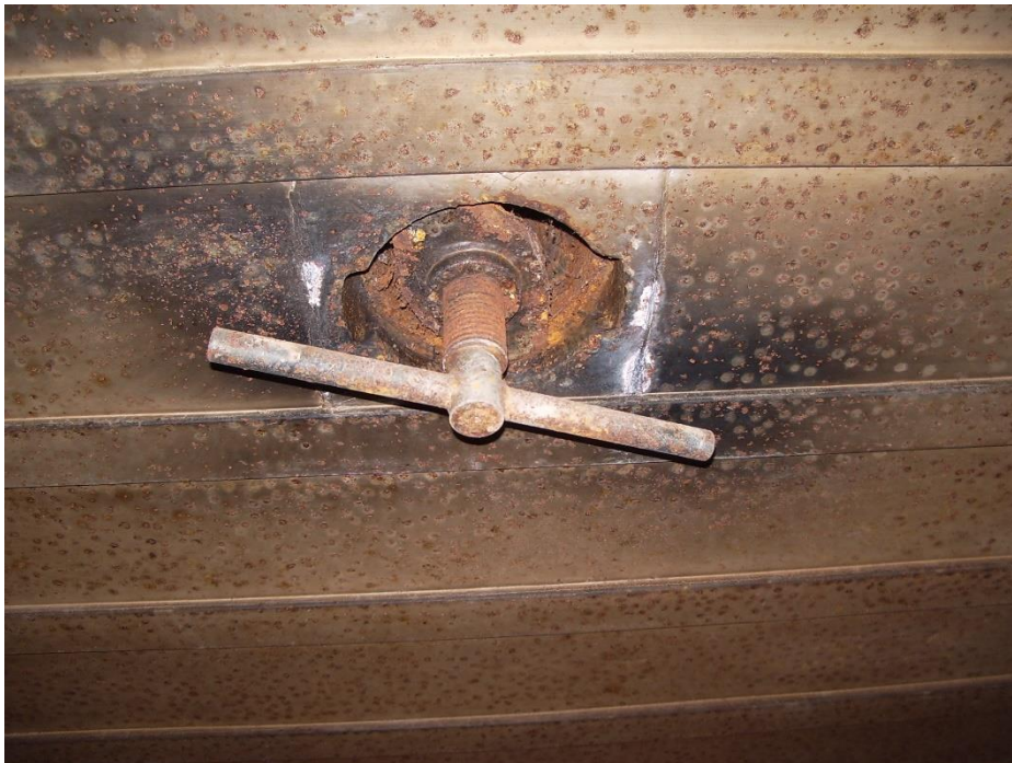
Exemple d'un tube blindé type 735P3 avec son obturateur encore en place et verrouillé. Blockhaus R118c, position Sa70, les Sables-d'Olonne. ©Graffard T.
