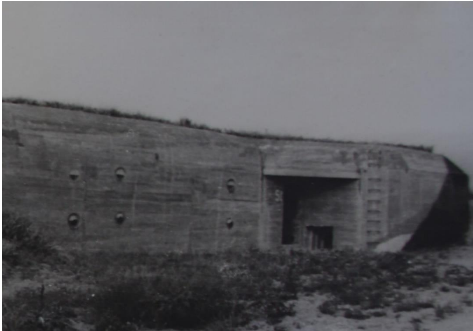
SHD – Rochefort, cote 1 W 53. Photographie du poste d'observation R613 à l'issue de la retraite allemande.
