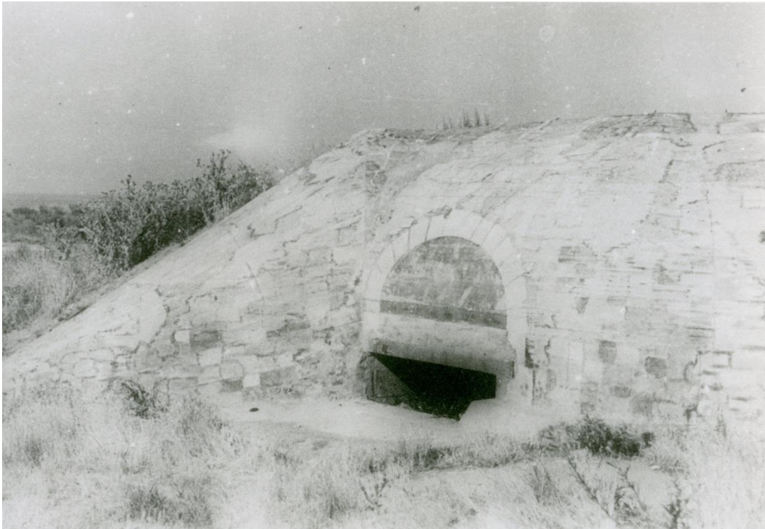
AMSO, cote 13Fi. Casemate R667 camouflée en ouvrage en pierre de taille sur le site de la Chaume.
