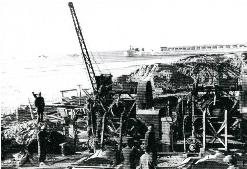
Illustration 24. Fabrication de la dalle d'un bunker sur le remblai.
