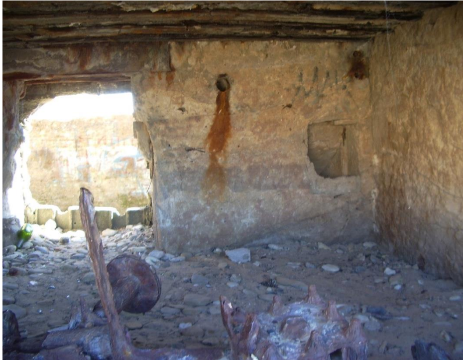
Mur sur lequel est fixé le dispositif d'aspiration. On remarque encore la bouche du rejet des gaz, à droite le regard d'extraction des douilles et au-dessus le passage des câbles de connexion. Point d'appui Sa64. ©Graffard T.
