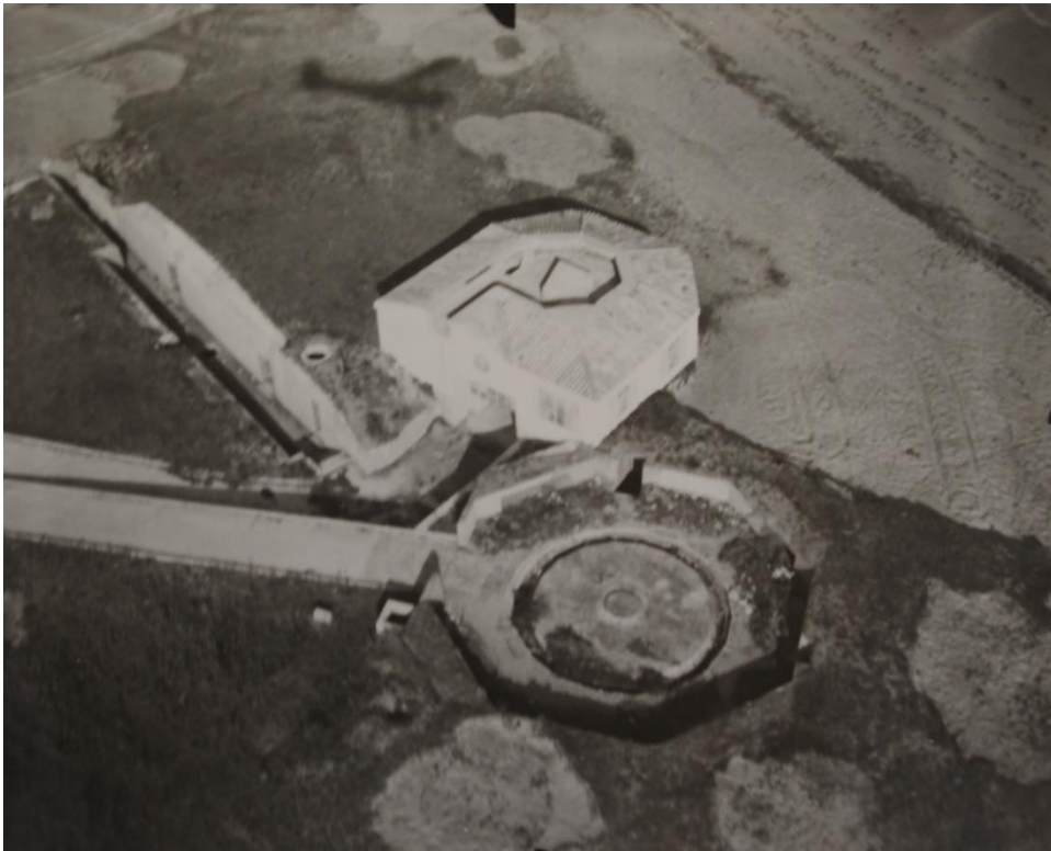
SHD – Rochefort, cote 1 W 1848. Vues aériennes d'une des casemates R669 avec un encuvement pour Flak 30 sur le toit. À noter aussi la présence d'un encuvement pour obusier, ainsi que l'abri R502 à proximité.
