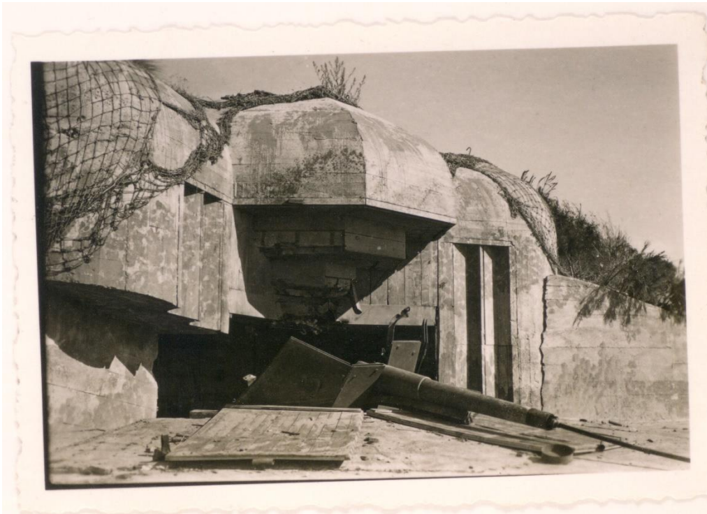
AMSO, cote 16Fi. Photographie de l'embrasure du R652 après le retrait des troupes allemandes. On peut remarquer l'imposant 10,5 cm K.331.
