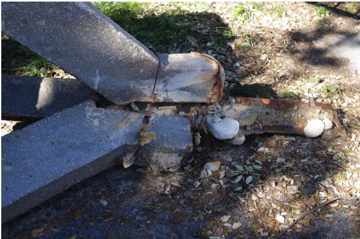
Détails du sommet d'un des tétraèdres retrouvés au Veillon. On remarque une pièce métallique servant à évanter les coques lorsque le dispositif est immergé. ©Graffard T.
