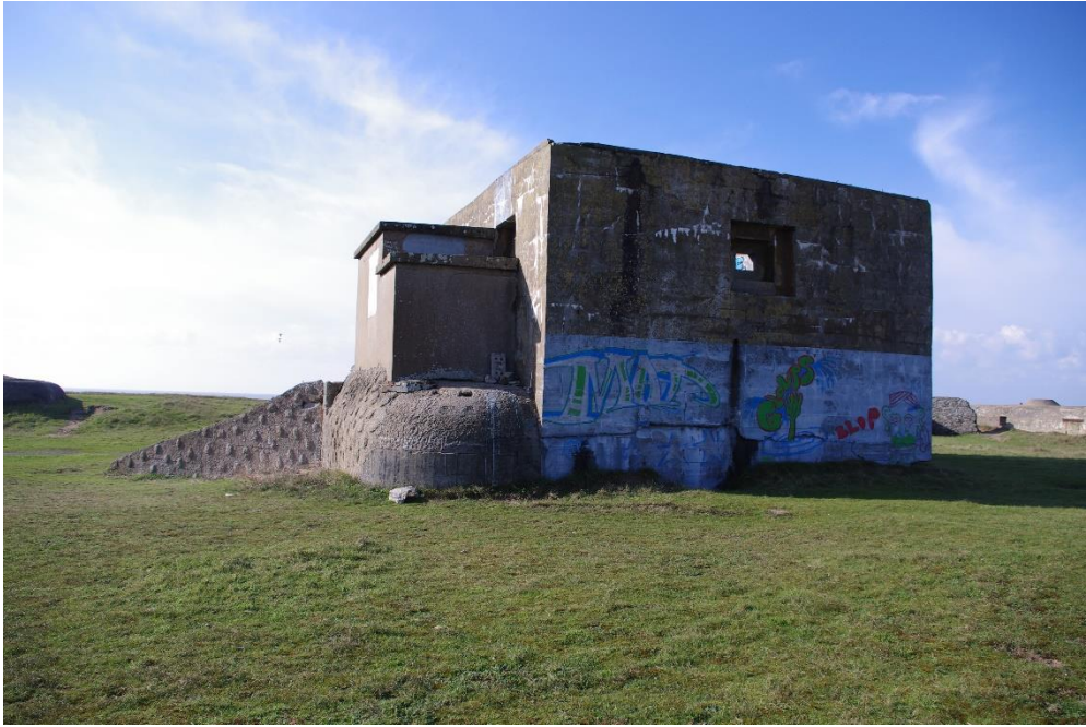
Vue opposée de la cuve pour radar, où l'on distingue deux des trois créneaux de tirs pour la défense du site. On remarque également les formes de l'abri R501 servant de fondation. ©Graffard T.
