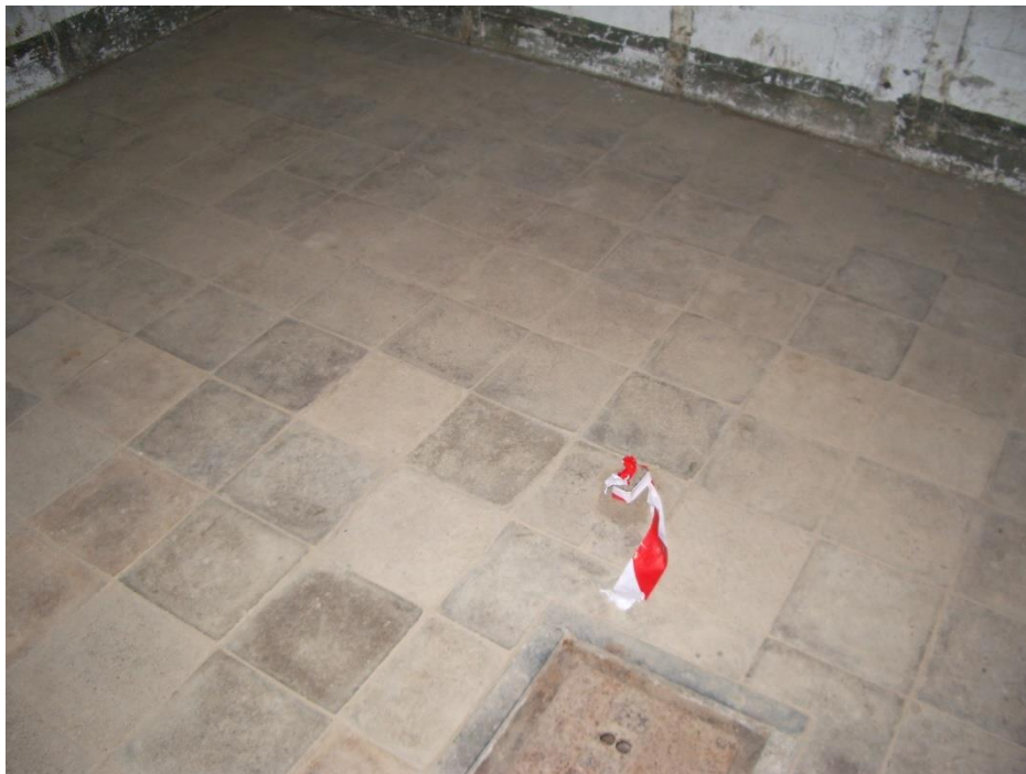
Salle d'opération carrelée avec sa poubelle de sol au premier plan. Blockhaus hôpital 118c, Sa70 – Les Sables d'Olonne. ©Graffard T.
