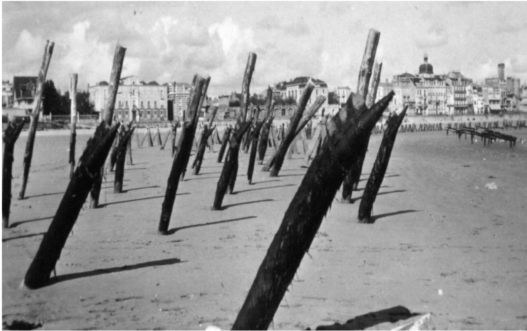
AMSO, cote 16Fi. Exemple d'installation avec un obus fixé à un pieu face à la mer. Photographie prise aux Sables-d'Olonne, sûrement après la retraite allemande en septembre 1944.
