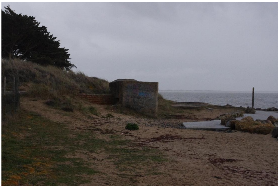
Un des tobrouk et l'encuvement pour 50 KwK à la pointe de la Loire, position Sa112. À noter que l'on aperçoit le tunnel en briques à gauche. ©Graffard T.
