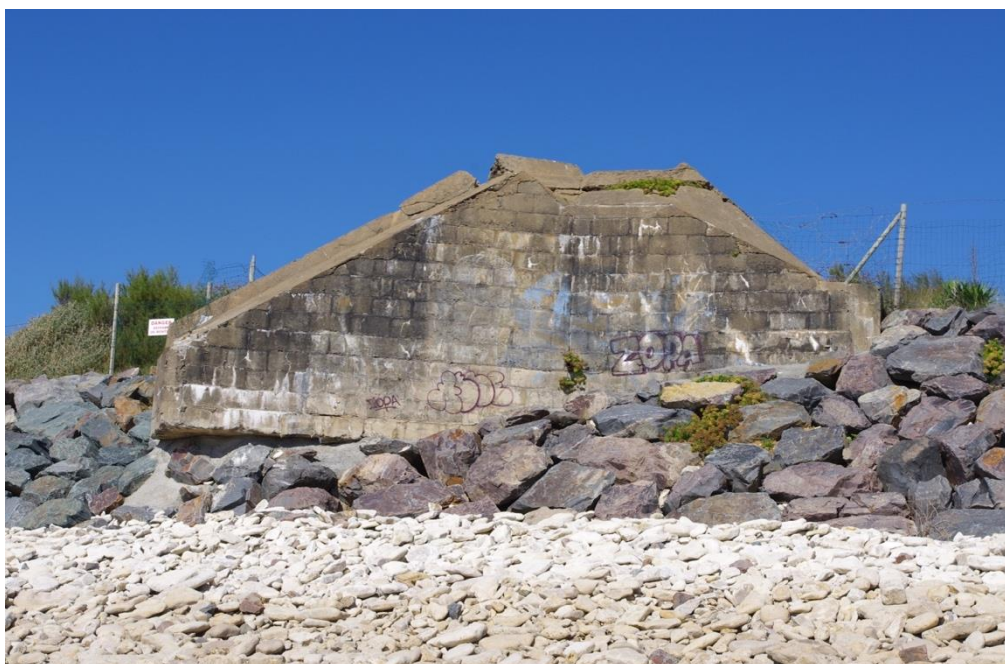
Photographie du flanc gauche d'un R667 parallèle à la mer. À noter la cascade d'angles acérés à son sommet pour retenir le remblai aujourd'hui disparu. Jard-sur-Mer Sa78.
