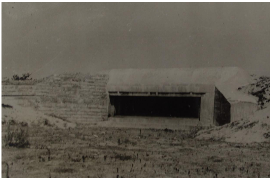
SHD – Rochefort, cote 1 W 1848. Photographie de l'embrasure du R219 construit à la Tranche-sur-Mer (Sa86). À noter le camouflage façon « briques ».
