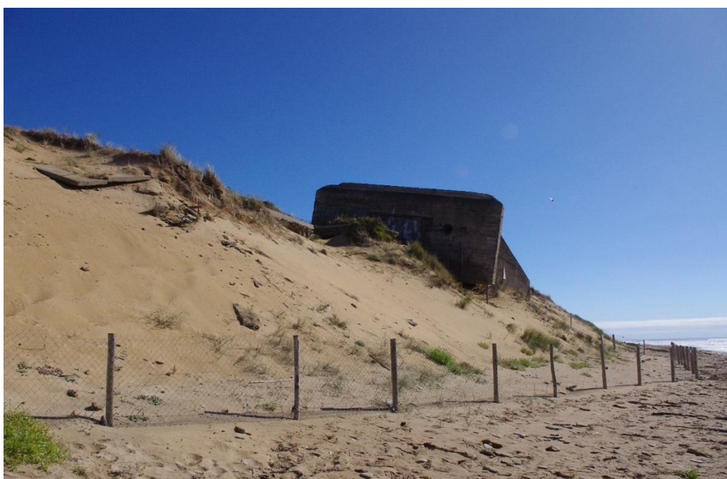
La position Sa64 de la Grenouillère en septembre 2017. La plateforme est visible à droite, mais aucune trace du bâtiment à gauche. ©Graffard T.
