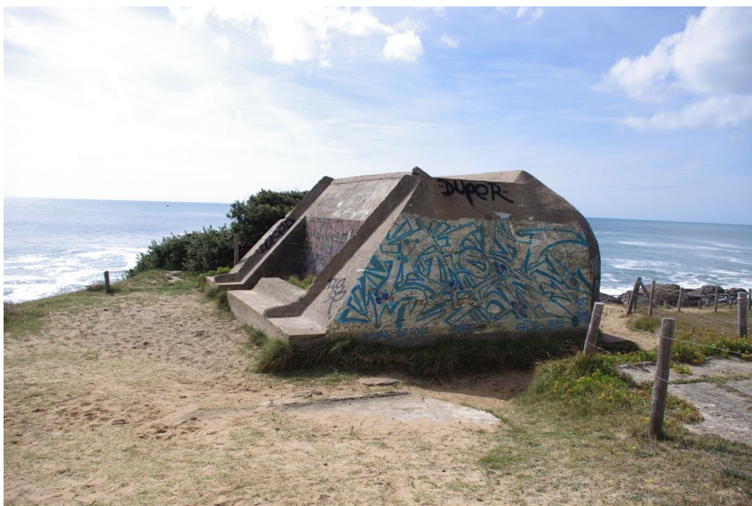
Photographie d'un blockhaus R667 présentant les différentes crêtes qui lui assurent de garder le remblai sur le toit, mais aussi d'y fixer les filets de camouflage. Point d'appui Sa74.
