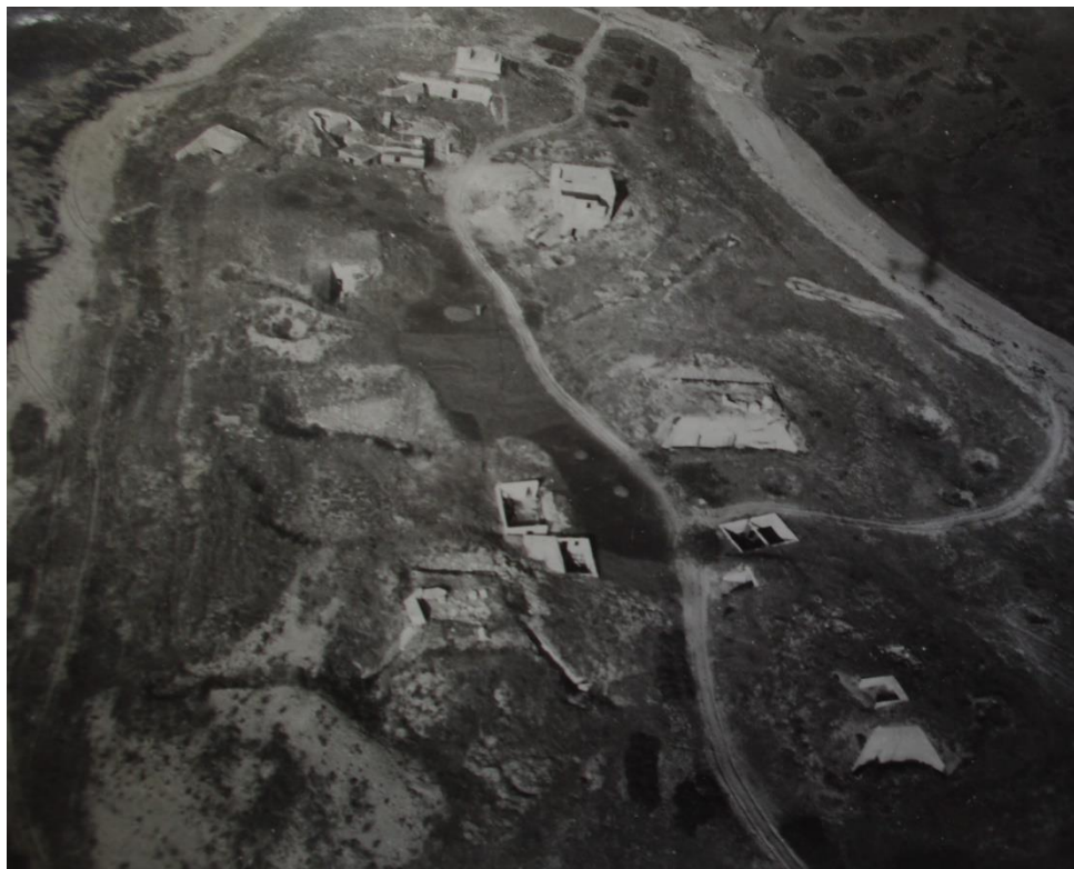
SHD – Rochefort, cote 1 W 53. Vue aérienne du point d'appui Sa106 de la pointe de L'Herbaudière après-guerre.
