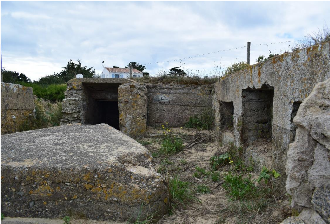
Vue intérieure de l'encuvement, avec au fond l'abri pour la troupe. ©Graffard T.
