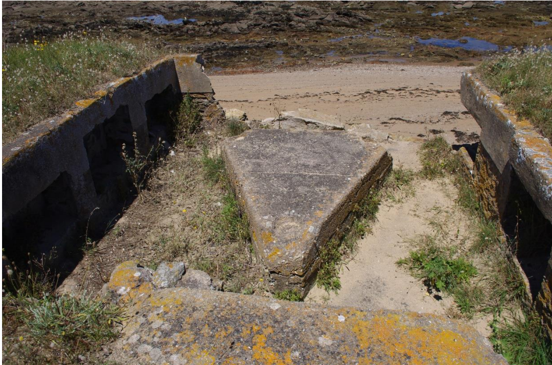
Vue intérieure de l'encuvement, avec, de chaque côté, les niches à munitions. À noter le mélange pierres-béton à gauche. ©Graffard T.
