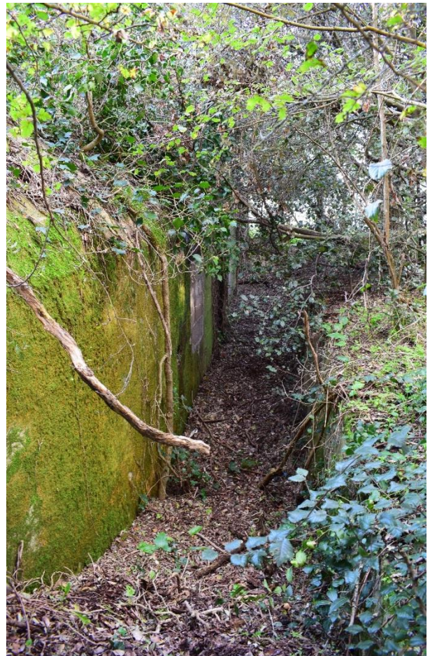
Blockhaus R621 à la position Sa70 aux Sables-d'Olonne. On remarque sur la photographie de gauche, l'aile aidant à retenir le remblai. Puis, sur la seconde, les accès vers le bunker, sécurisés par un muret en béton à droite. ©Graffard T.
