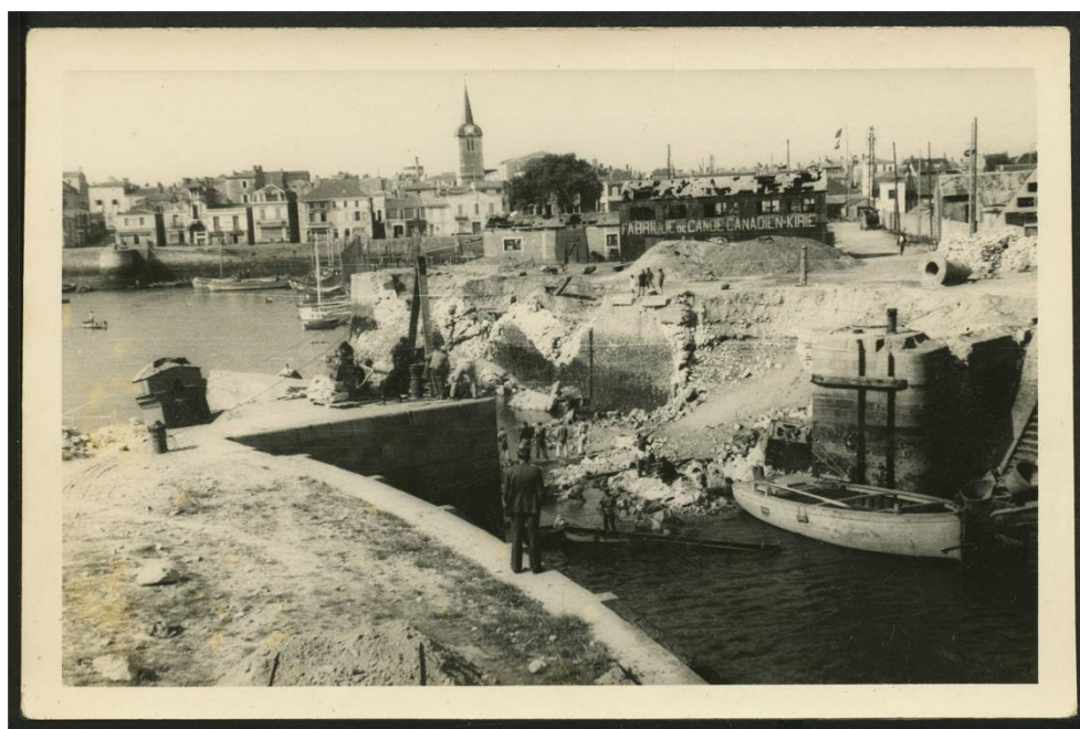
AMSO, cote 15Fi. Photographie de la porte du bassin à flot sabotée lors de la retraite des troupes allemandes des Sables-d'Olonne.
