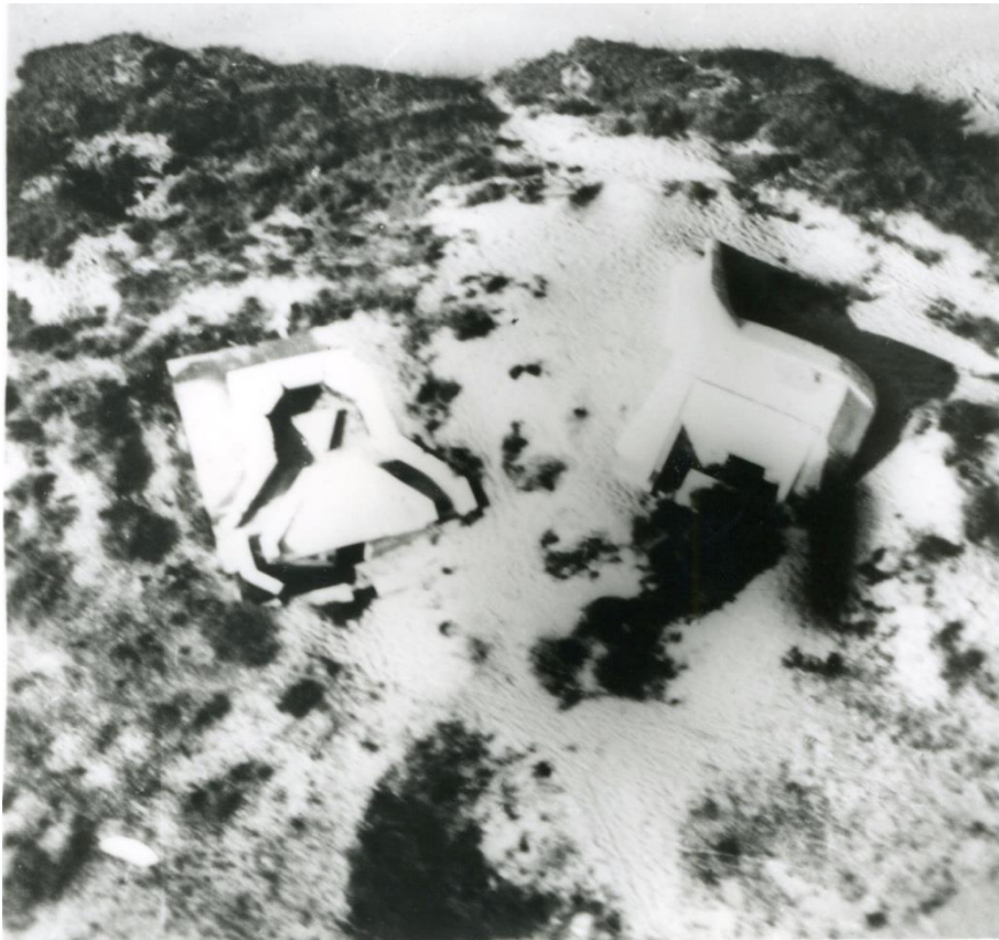
AMSO, cote 13 Fi. Point d'appui Sa72 de la Rudélière. Le R600 à gauche, on aperçoit le support triangulaire pour le canon de la Flak, de même que l'entrée de l'abri souterrain.
