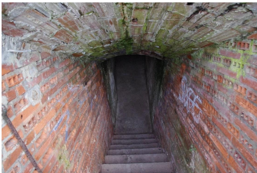
L'entrée du tunnel menant à la soute à munitions, mais aussi aux ouvrages extérieurs. Position Sa112. ©Graffard T.
