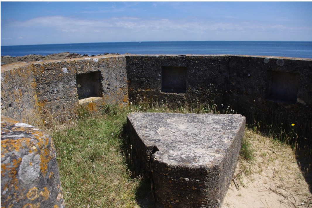
Vue actuelle depuis l'encuvement. À noter le support ainsi que les différentes niches pour les besoins du canon antiaérien. ©Graffard T.
