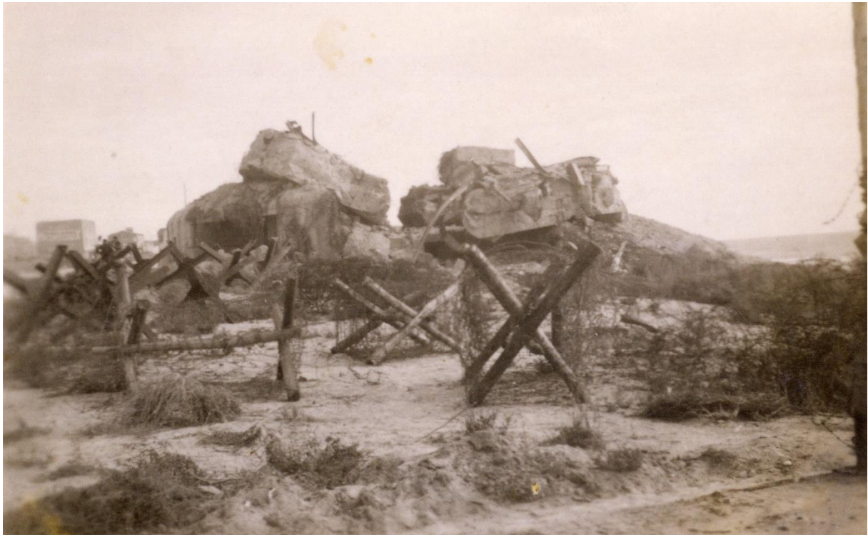
AMSO, cote 16Fi. Au premier plan, des chevaux de frise en bois.
