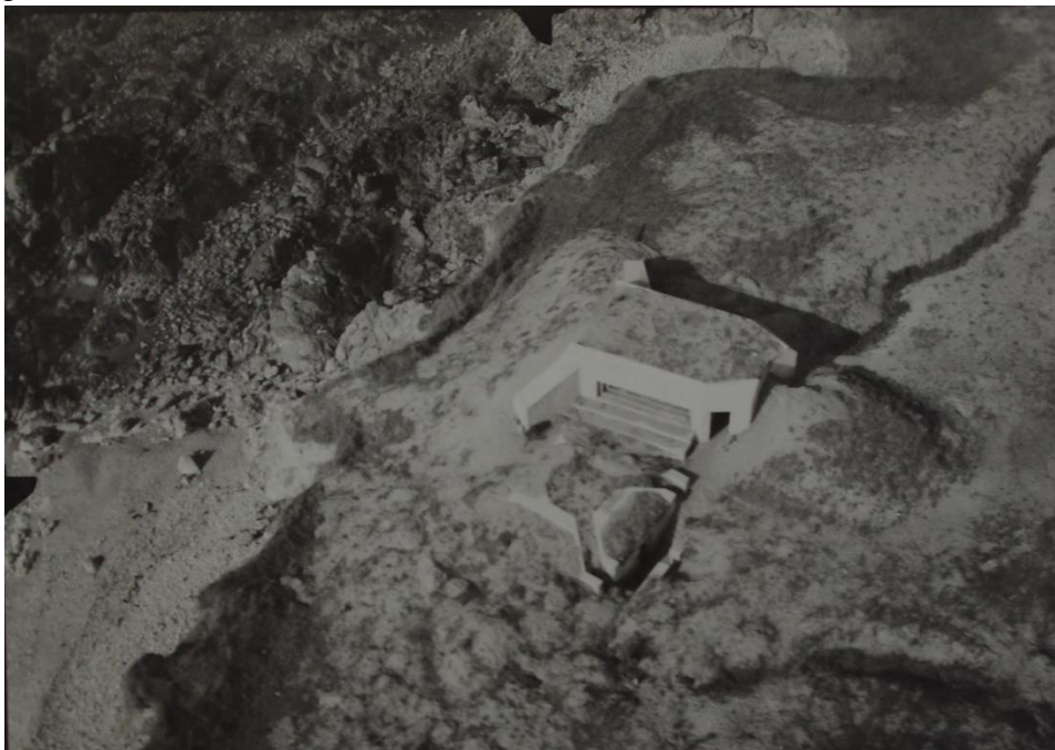
SHD – Rochefort, cote 1 W 1848. Vue du blockhaus R219 à double embrasure à Saint-Jean d'Orbestier (Sa17). À noter la présence d'une première casemate R600 et les vestiges de tranchées.
