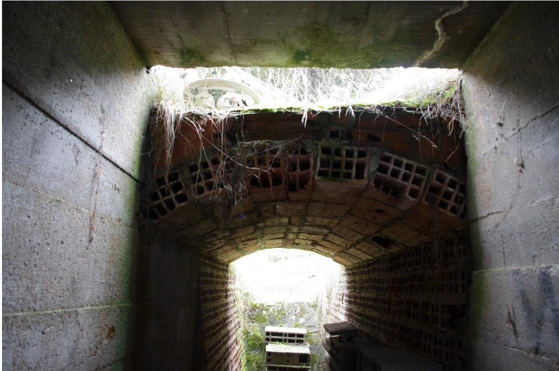
À l'intérieur de la soute à munitions, position Sa109. À noter ici l'inclinaison des murs de briques, la mixité des matériaux utilisés, ainsi que la remarquable condition de la structure. ©Graffard T.
