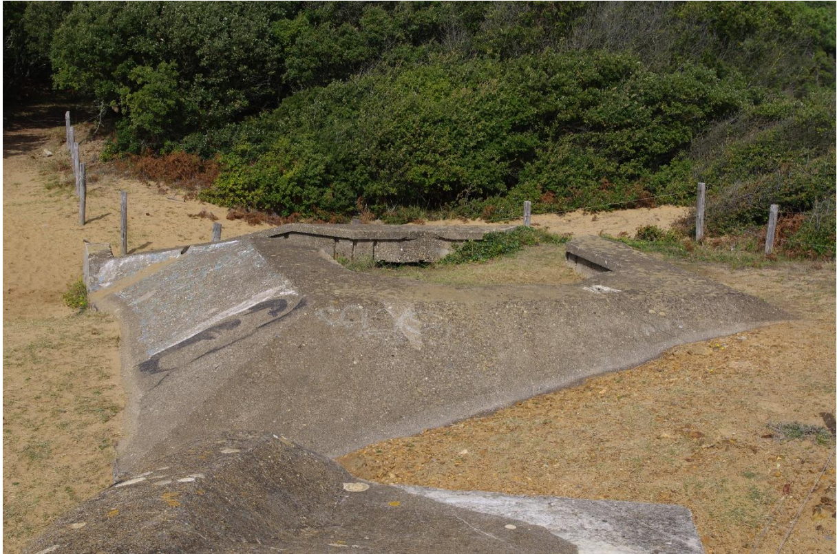
Mise en situation du regelbau R600 au point d'appui Sa74 à Cayola. ©Graffard T.
