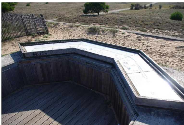
Illustration 35. Intérieur de l'encuvement du second R600 avec la mise en place du bardage en bois et de la table d'orientation.
