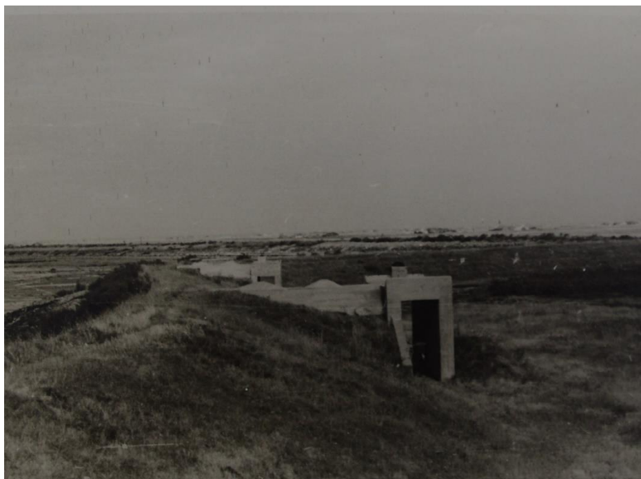
SHD – Rochefort, cote 1 W 1848. Vue de la position de la pointe des Polous après-guerre. On remarque deux des quatre abris Vf 1b.
