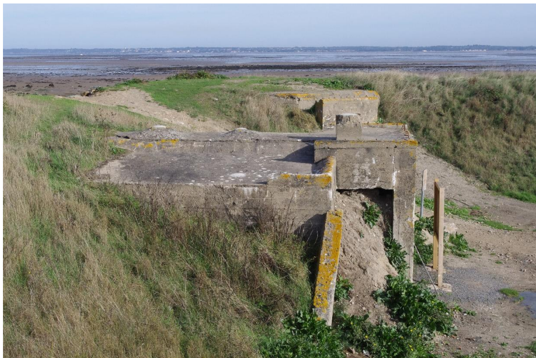
La pointe des Polous actuellement. Vue d'un des abris Vf 1b intégrés à la digue avec comme particularité une extension. Il est à noter que ces versions sont équipées de crochets permettant d'y fixer des filets de camouflage. ©Graffard T.
