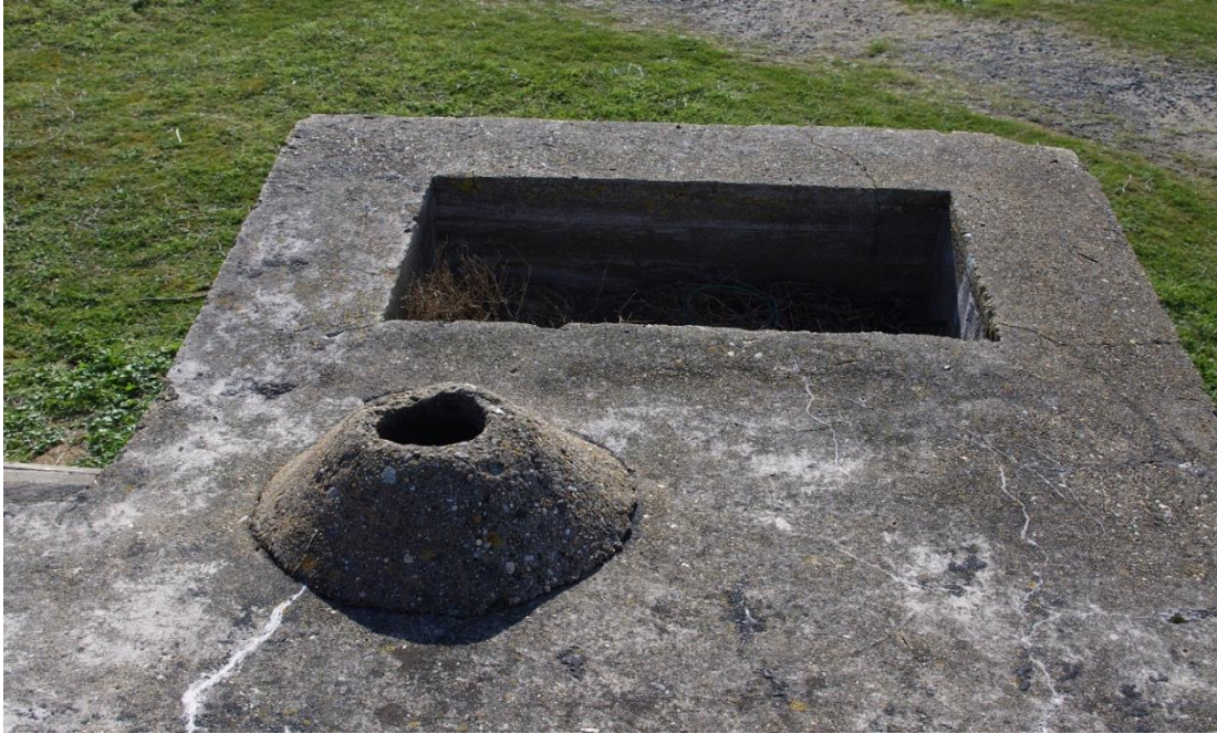
Détails de la cheminée du poêle de forteresse ainsi que de la sortie de secours qui fait également office de bac de réception pour le système anti-grenade. Point d'appui Sa106, L'Herbaudière, Noirmoutier. ©Graffard T.
