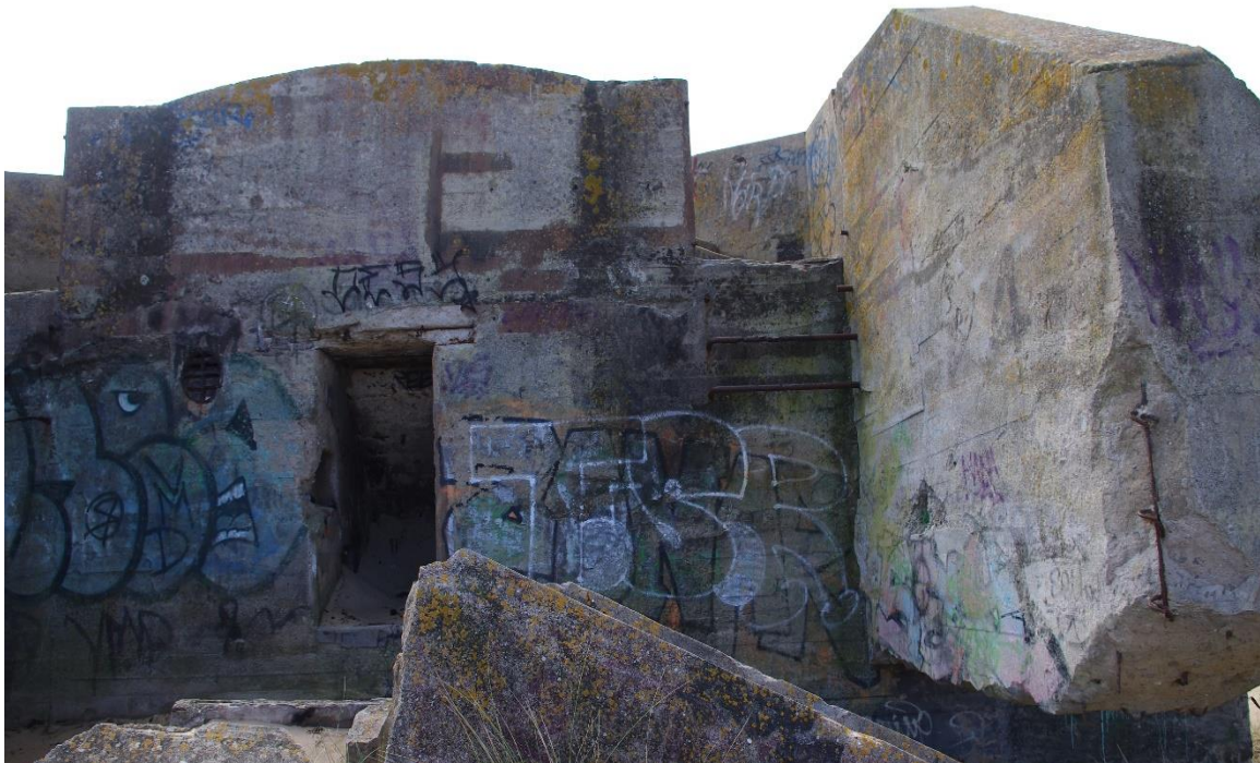
Vue arrière du R600 où l'on remarque l'entrée, la bouche d'aspiration d'air frais à gauche ainsi que les barreaux permettant l'accès à l'encuvement. Point d'appui Sa115, Noirmoutier.
