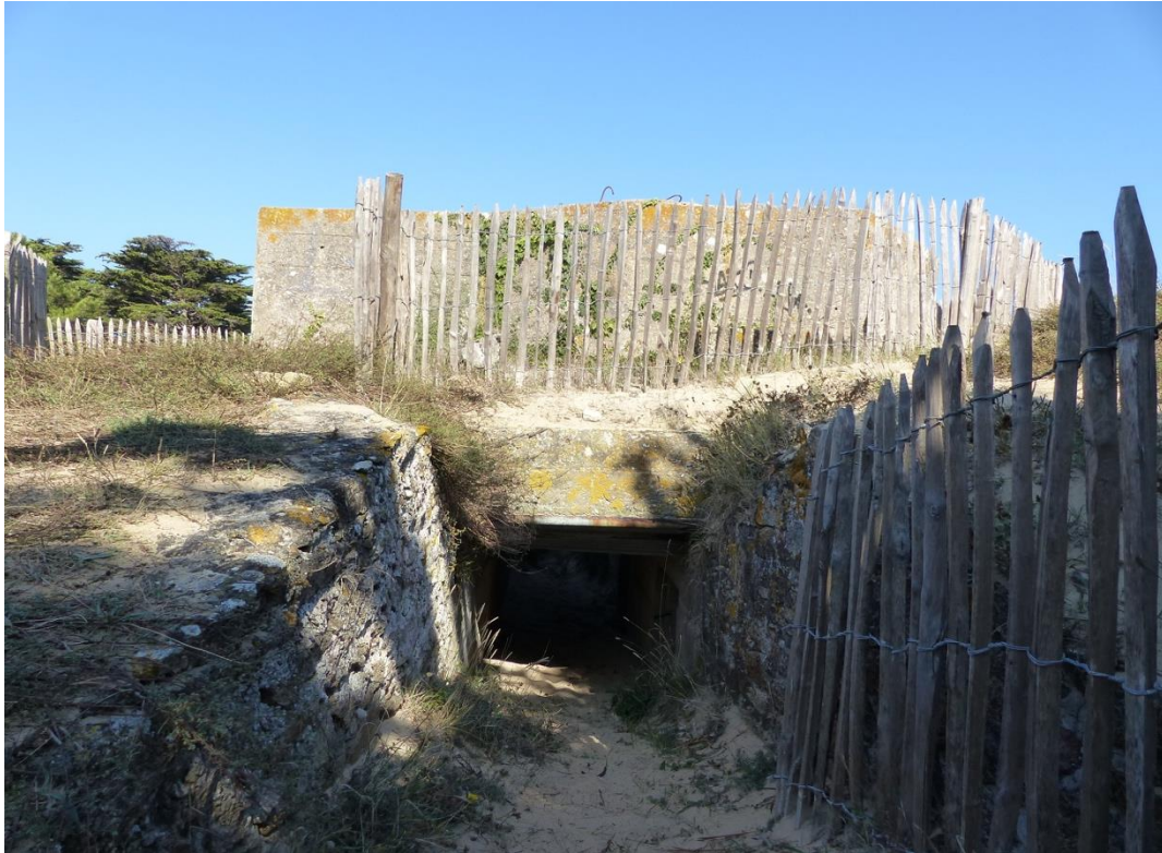
Photographie de l'entrée est menant aux deux soutes placées sous l'encuvement. À noter l'usage de la pierre ainsi que l'épaisseur de la dalle supérieure de l'ouvrage. Crédits : Service patrimonial de l'île d'Yeu.
