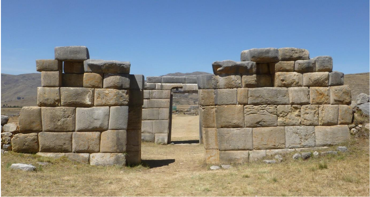
Figure 13. Appareil typique inca observé sur le site de Huánuco Pampa (province de Dos de Mayos), Chinchasuyu (crédits photo : David Barreiro)
