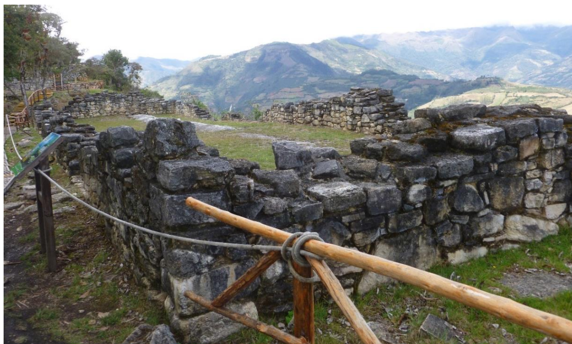
Figure 24. Kallanka inca implantée dans la partie nord-ouest du site de Kuelap (province de Luya), Chinchasuyu (crédits photo : David Barreiro)
