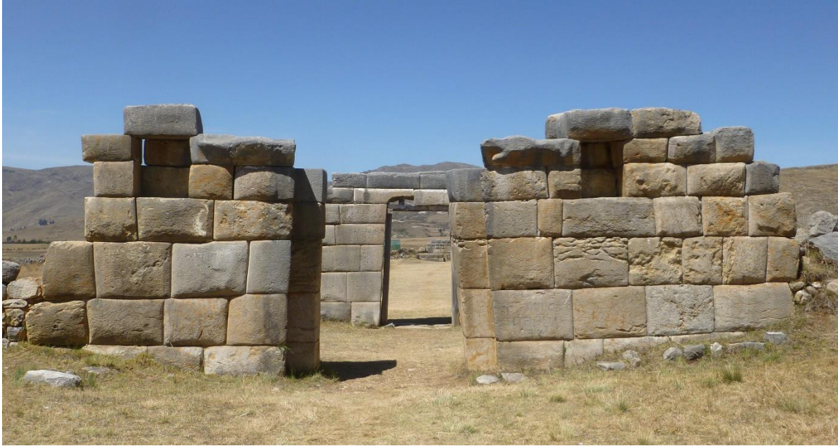
Figure 13. Appareil typique inca observé sur le site de Huánuco Pampa (province de Dos de Mayos), Chinchasuyu (crédits photo : David Barreiro)
